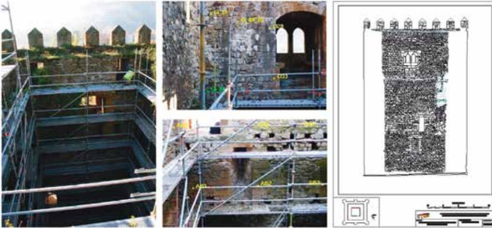
Figura 18.- La imagen de la izquierda corresponde a una vista general del estado del interior de la torre durante el trabajo de documentación. Las dos imágenes centrales son los croquis de dos pares fotogramétricos en los que se aprecia cómo aparecían los andamios (los números corresponden a los puntos de apoyo). A la derecha se presenta el dibujo final, producto de la restitución estereoscópica manual.
