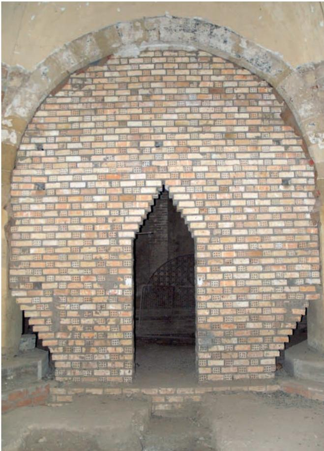
Figura 26. Apeo de arco con muro de ladrillo.
