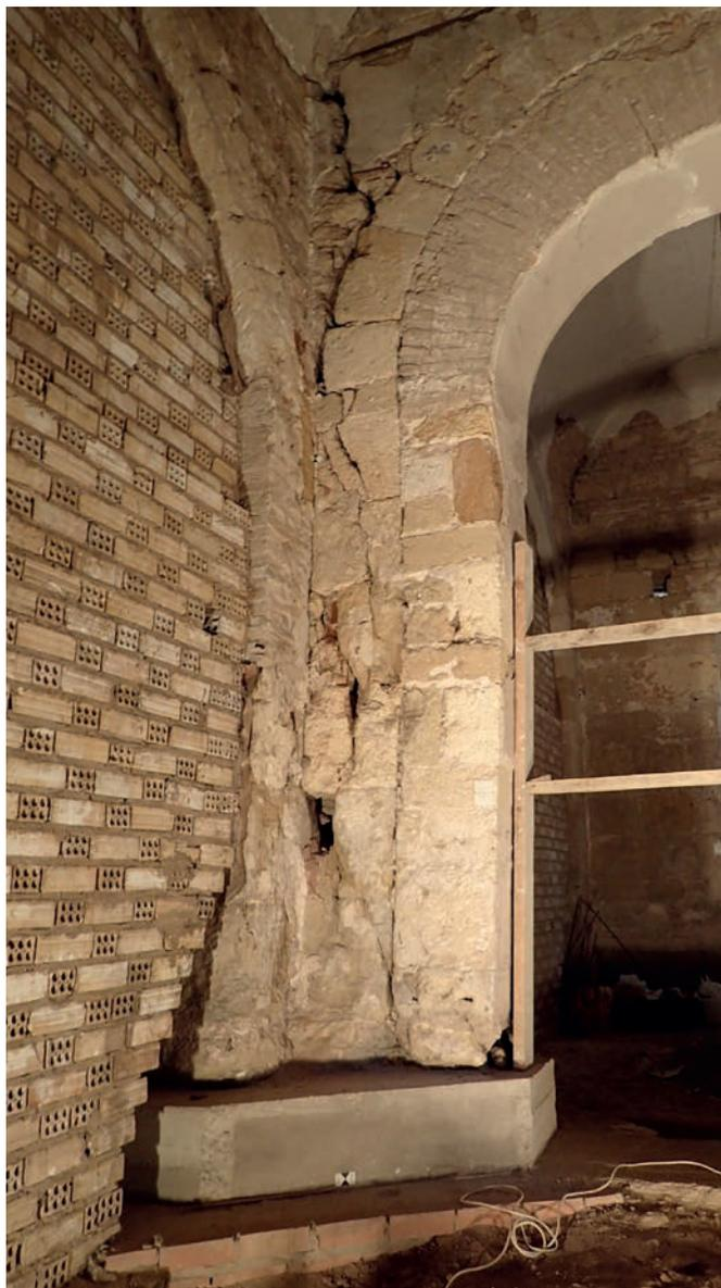
Figura 24. Pilar cruciforme del interior la iglesia con fuertes deformaciones y agrietamientos.
