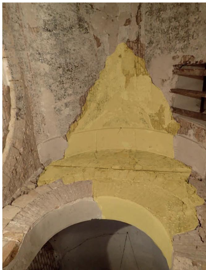
Figura 11. Formación de bloque en arco y bóveda mediante grietas.
