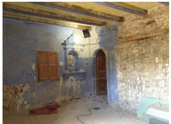
Figura 24. El daño provocado por el picado del revestimiento renacentista realizado en la cuarta sala renacentista del Palacio del Barón de Herbés (Herbés, Castellón) antes de su estudio y proyecto de restauración. Fotografía Mileto y Vegas.
