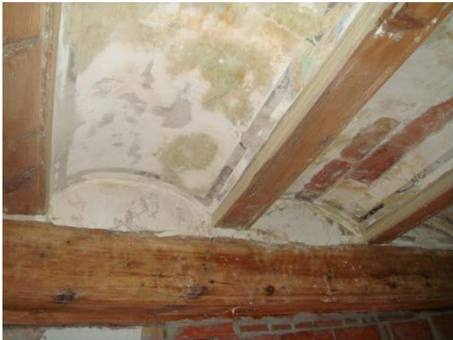
Figura 14. Forjado del siglo XVIII con decoración esgrafiada encontrado en la crujía trasera del edificio de viviendas en la Calle Maldonado 33 (Valencia). Fotografía Mileto y Vegas.
