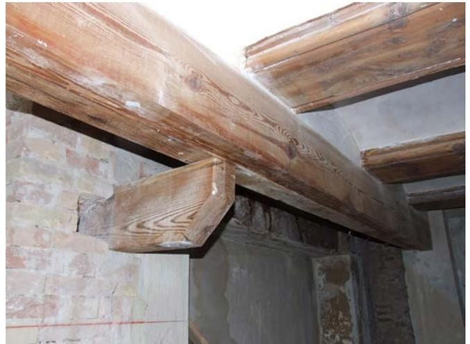
Figura 15. Viga paralela a la fachada que aguanta el forjado de la primera crujía del edificio de viviendas en la Calle Maldonado 33 (Valencia). Fotografía Mileto y Vegas.
