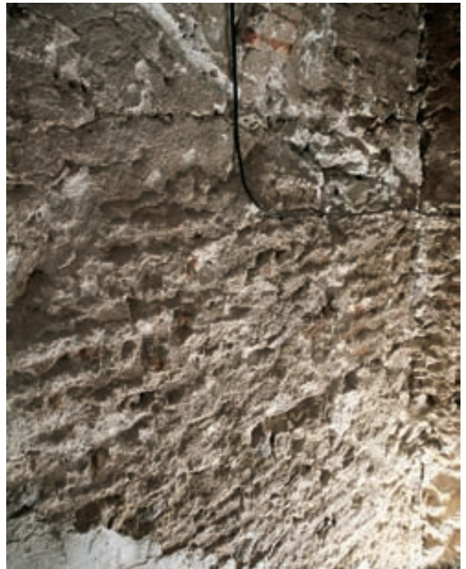
Fig. 9. Huella del muro de ladrillo y barro, utilizado como encofrado del muro perimetral de calicanto en cuya superficie se conserva [A100 UE 1022]. Planta 1.ª, muro N
