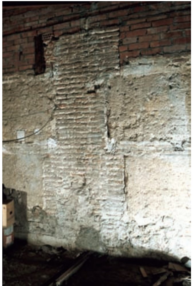
Fig. 18. Cara exterior del muro N de la iglesia, de verdugada y tapial [A100 UE1094]
