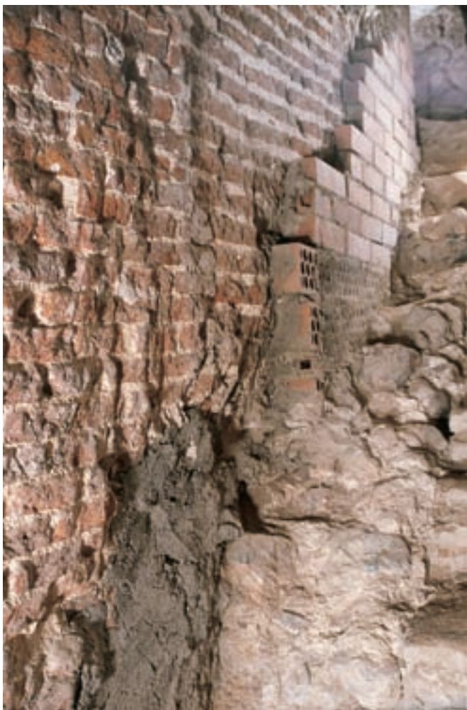
Fig. 7. La pared del machón central desde la puerta de entrada, planta 1.ª cara E. En primer término la reforma de la jamba de entrada [A101 UE1003]. A la izquierda, el muro de ladrillo del machón [A100] con el corte de época moderna [A105 UE 1001]. A la derecha el muro de ladrillo y barro [A100 UE1087] y el cimiento de calicanto [A100]. Entre ambos la intervención de A. Berlinches [A137]
