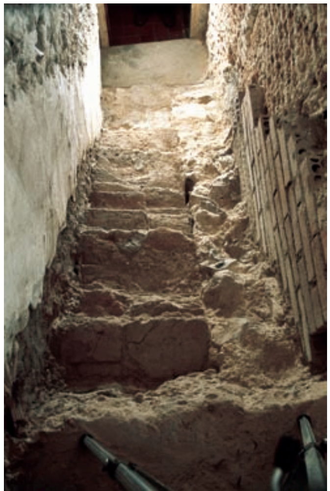
Fig. 8. Primer tiro, oriental, de la planta 1.ª, bajando. En el centro el muro de barro [A100 UE1087] y el cimiento de calicanto del machón [A100]. Inmediatamente a izquierda y derecha, la restauración de A. Berlinches [A137]. A continuación la obra original [A100], a la izquierda el muro perimetral de calicanto y a la derecha el muro de ladrillo del machón cortado en época moderna [A105]
