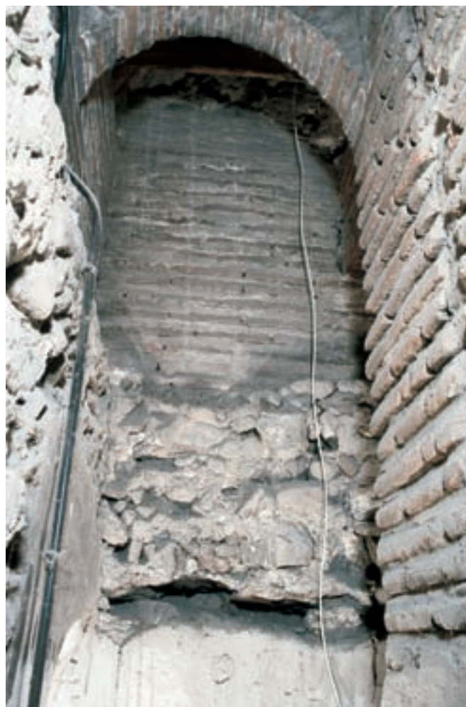
Fig. 10. Paso de la fábrica de calicanto a la de ladrillo [A100]. Planta 1.ª, muro 5
