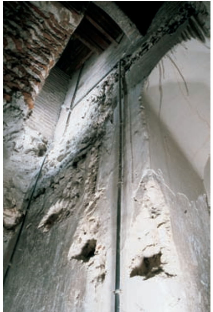
Fig. 4. La entrada al coro moderno [A105 UE1034], planta 2.ª, muro E. En primer término el paso al coro con su cubierta buzada. En la pared perimetral los huecos de los ataques originales, indicando el rebaje moderno del nivel de escalera. A la izquierda el muro de ladrillo del machón central con el corte de época moderna. En los muros perimetrales, originales, se puede adivinar el paso de la obra de calicanto a la de ladrillo
