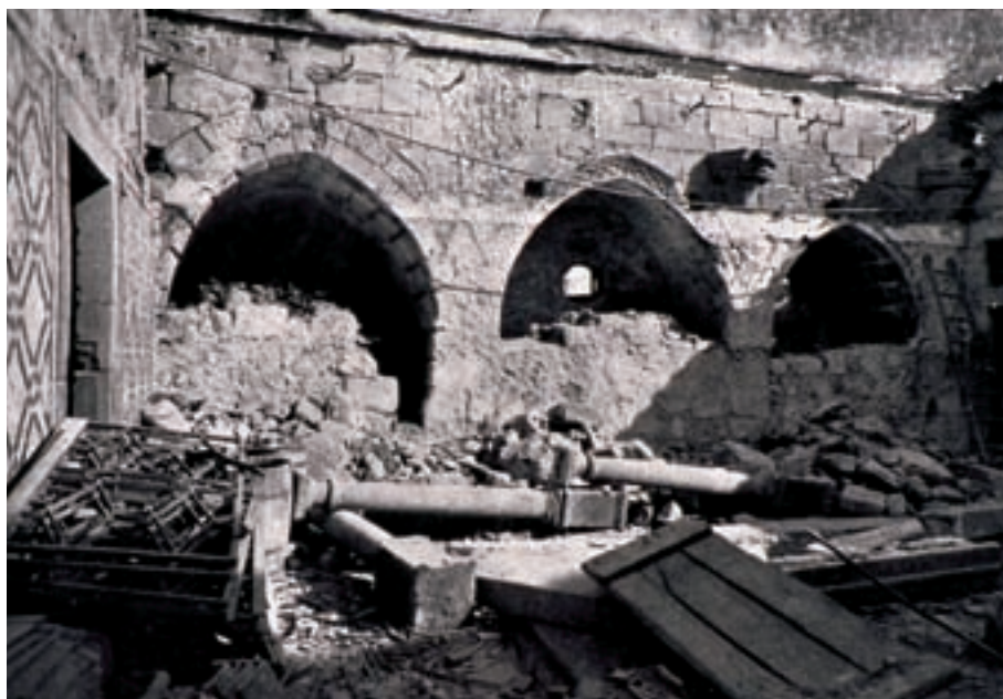
Sé Catedral do Porto durante as obras de restauro. Boletim da DGEMN n.º 40-43, 1946
