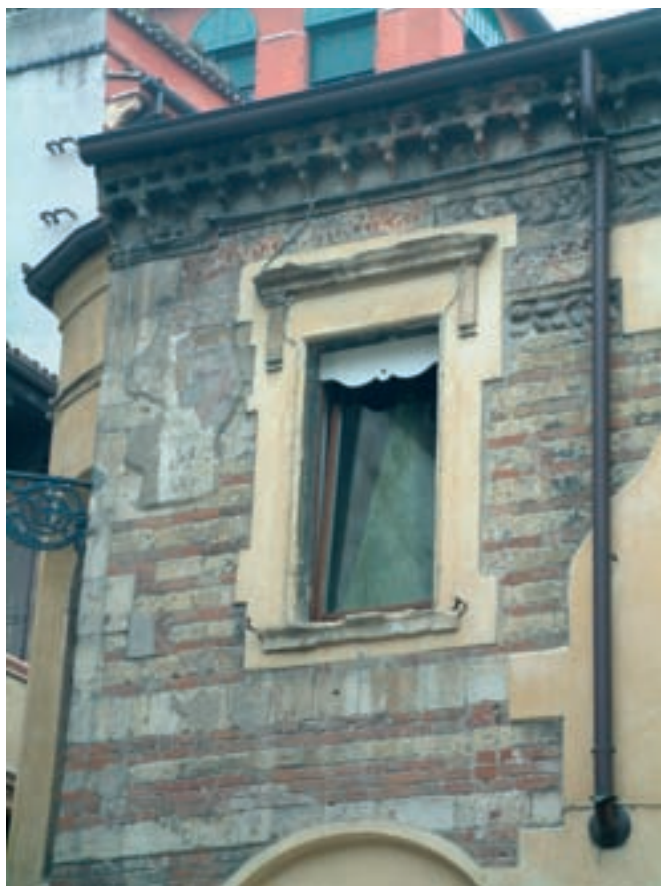
Fig. 6. Ostentación de la estratificación en la fachada de la iglesia de San Giovanni in Foro en Verona
