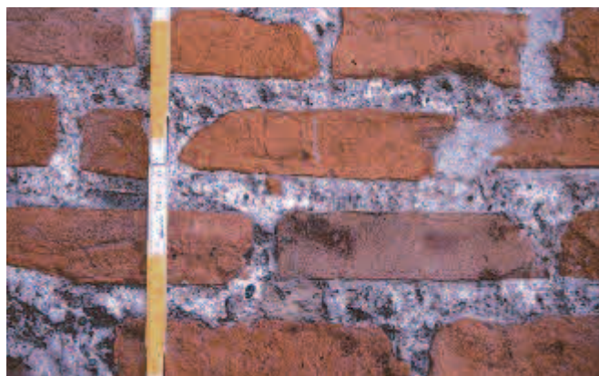
Fig. 4. Tessitura muraria tardoantica del teraonco
