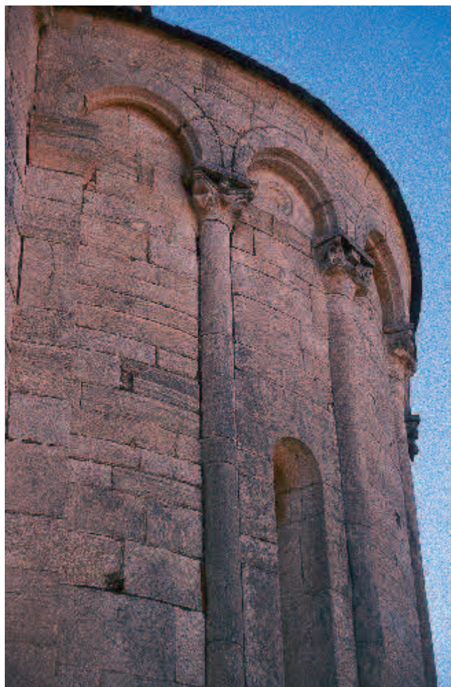
Fig. 3. Saint-Florent, cathédrale de Nebbio, détail de l'abside. On remarque, à mi-hauteur des colonnes, les blocs avec retours destinés à rigidifier la structure
