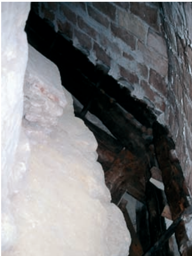
Detalle del extradós de la cúpula central. Obsérvese el apoyo de la cúpula sobre el encadenado de vigas de madera
