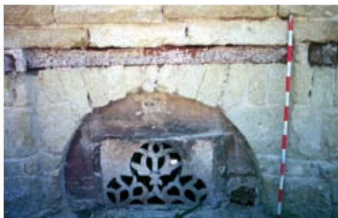
Lámina 12. Cúpula este, lado 3 (fotografía del alzado), obsérvese el encadenado de madera
