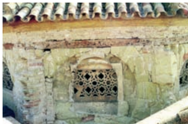
Lámina 17. Cúpula oeste, lado 10 (fotografía del alzado)
