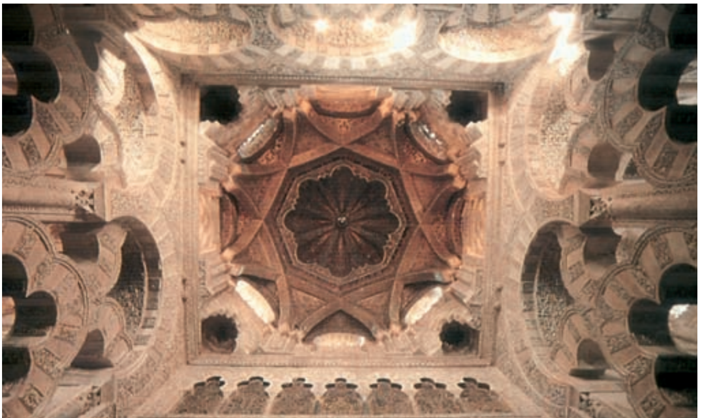
Interior de la cúpula central de la Maqsura
