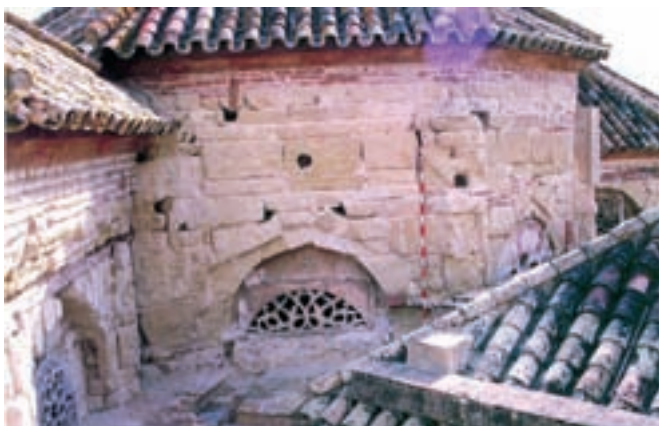
Lámina 2. Cúpula central, lado 5 (fotografía del alzado)
