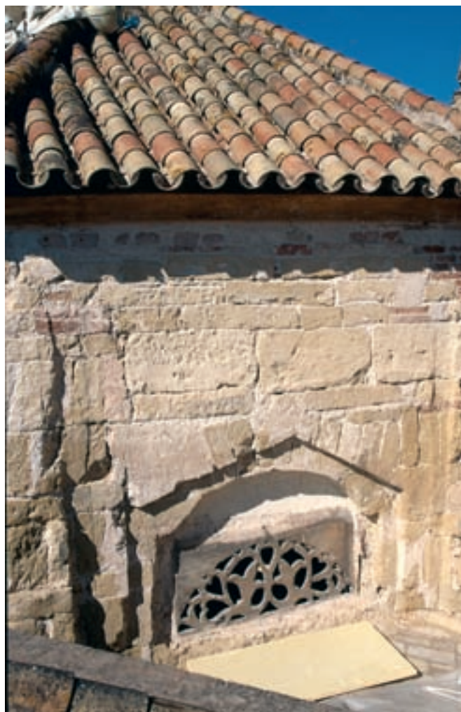
Linterna de la cúpula central, lado 17
