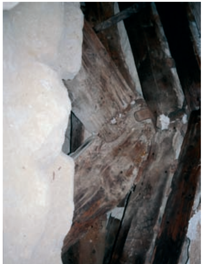
Detalle del encadenado de vigas de madera
