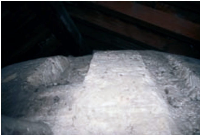
Extradós de la cúpula central. Obsérvese la presencia de rozas de la cubierta islámica
