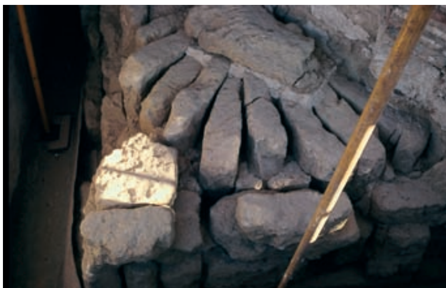
Detalle de la estructura que cubre a una de las falsas trompas de la bóveda lateral oeste
