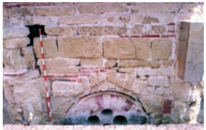
Lámina 4. Cúpula central, lado 6 (fotografía del alzado)
