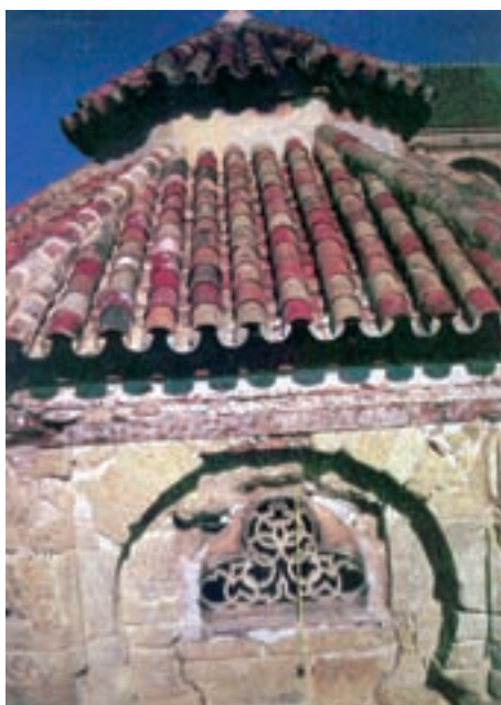
Lámina 21. Cúpula oeste, lado 13 (fotografía del alzado)
