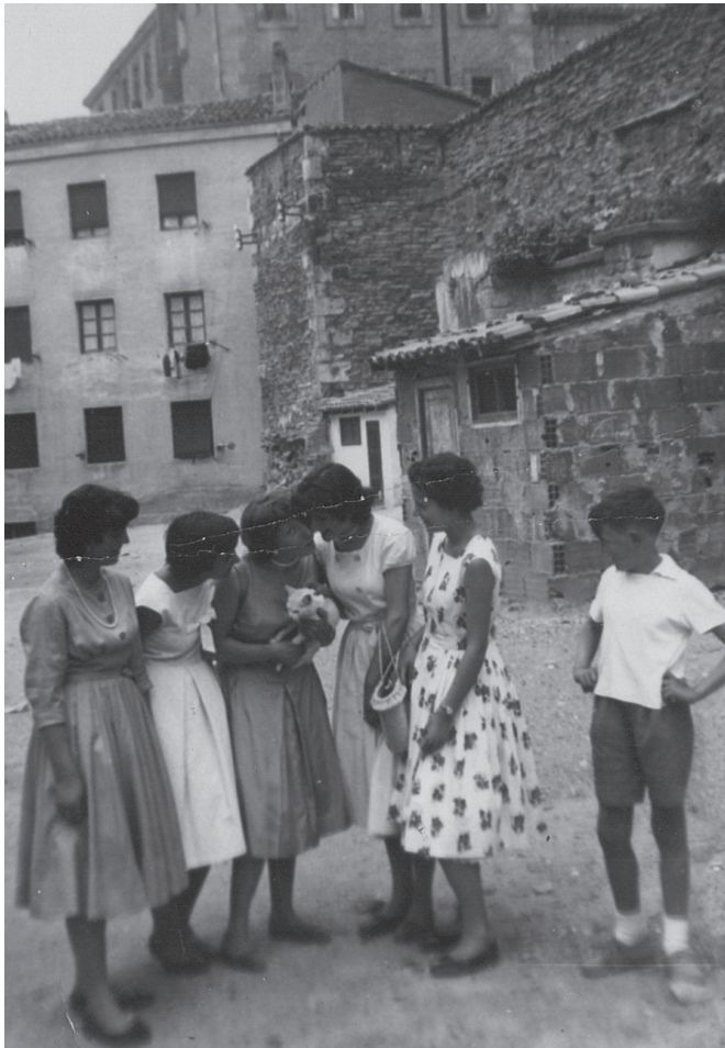
Fig. 5. Años 50. La muralla ha estado ahí desde el siglo xi. Agazapada, contemplando desde un segundo plano la vida que transcurría ante ella. En todo este tiempo, sus muros no han dejado de acumular información; el desmoche de sus torres, o esos cobertizos que vemos adosados en la imagen son muestra de ello. Foto: Begoña Anguita
