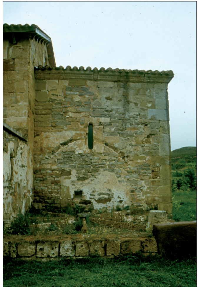
Fig. 2. Vista del muro Sur del ábside
