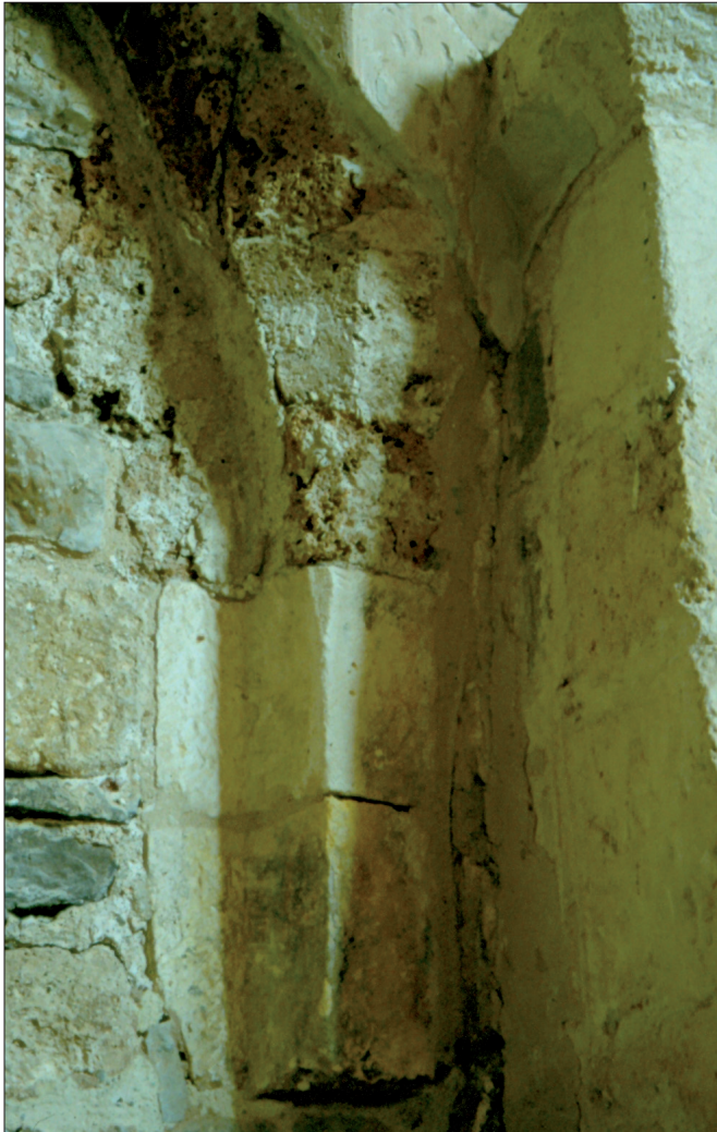
Fig. 16. Arranque de la pechina SO de la bóveda del ábside
