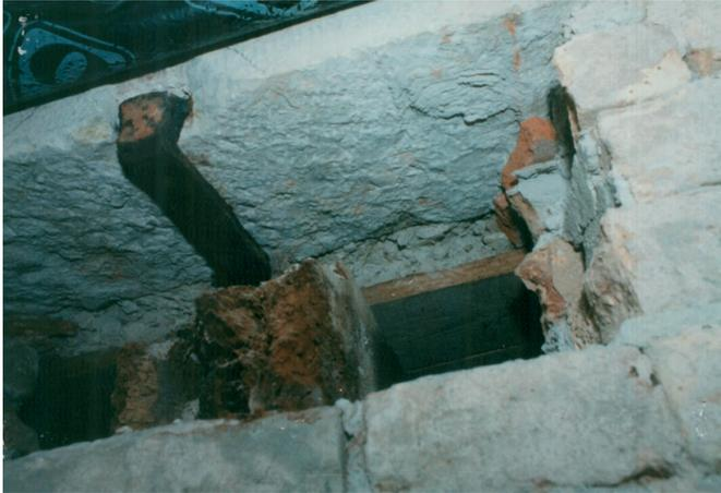
Fig. 1. Tipica connessione solaio-muratura denominata *fiuba* (Archivio Paper Less del Comune di Venezia)
