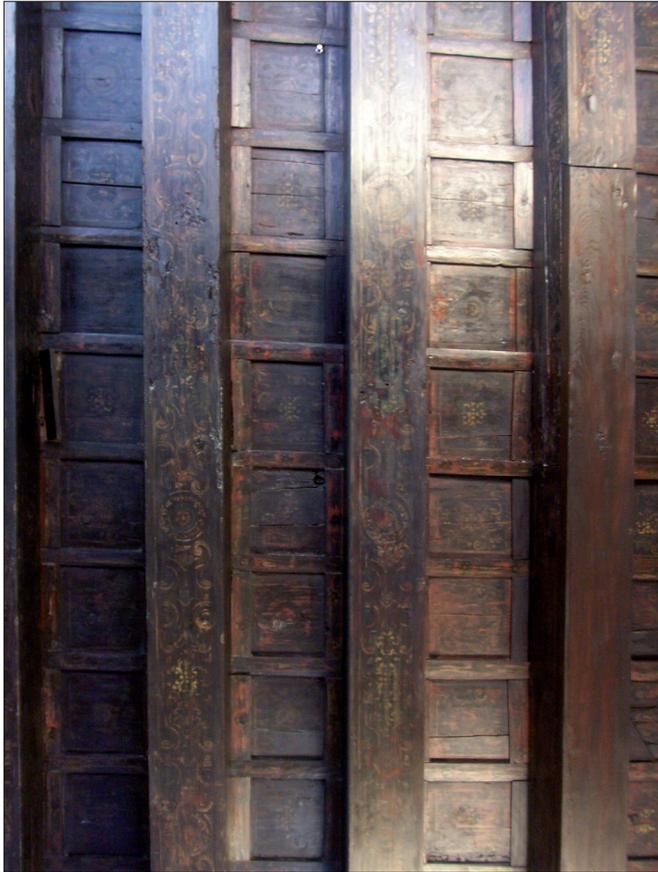
Fig.3. Dettaglio di solaio ligneo del periodo gotico (Ex Scuola dei Calegheri a San Tomà)
