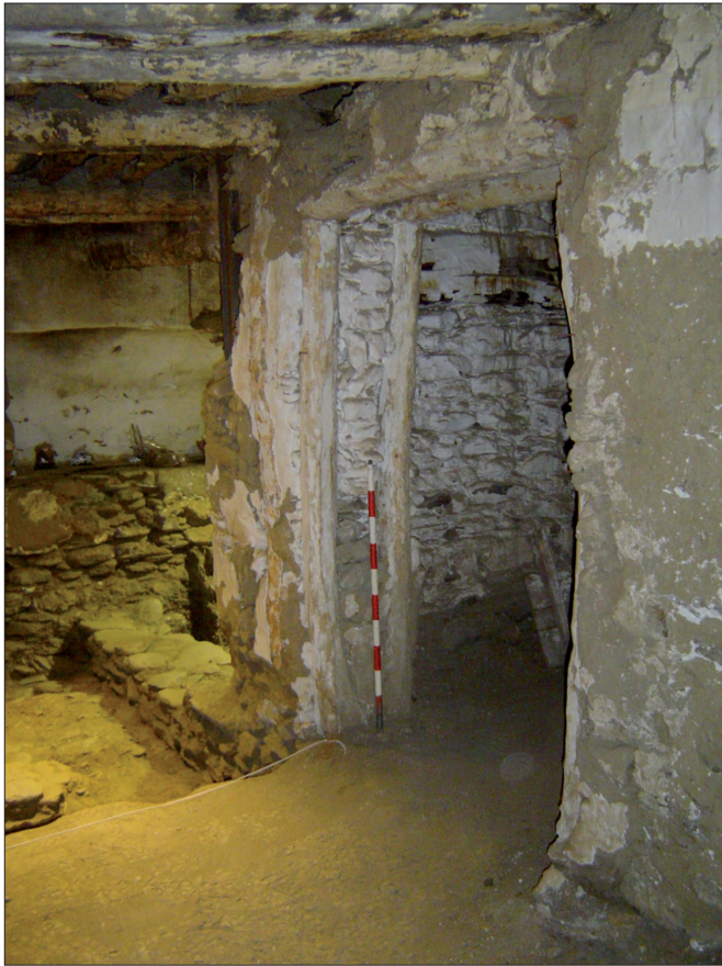
Fig. 14. Muro interior E5: documentación de la cimentación en el sondeo 1 en contacto con el muro perimetral E3, a la izquierda, y vano actual de comunicación, no original, a la derecha (vista desde el sector I)
