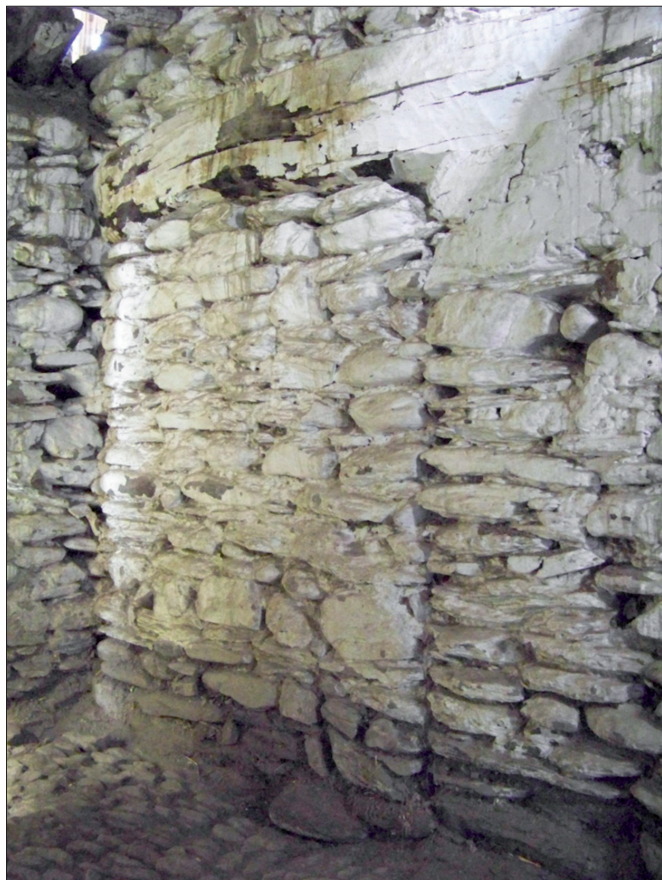
Fig. 16. Acceso original hacia el patio interior en el muro interior E6 (UE 10514), actualmente cegado (vista desde el sector IV)
