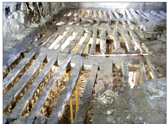
Fig. 22. Figura. Detalle de la cubierta de los sectores I y II
