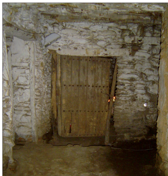
Fig. 18. Muro interior E7, vista del vano, probablemente original, de comunicación con el patio interior (UE 10529). Es el único de los tres vanos que consideramos originales que no ha sido tapiado y aún sigue utilizándose (vista desde el sector IV)
