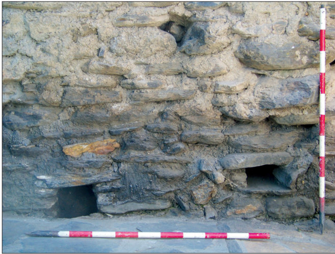
Fig. 20. Salida al exterior de dos canalizaciones existentes en la base del muro perimetral oeste E3 (UE/S 10347 y 10348)
