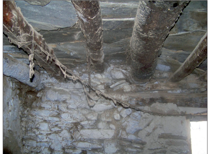
Fig. 21. Detalle de la cubierta del sector III
