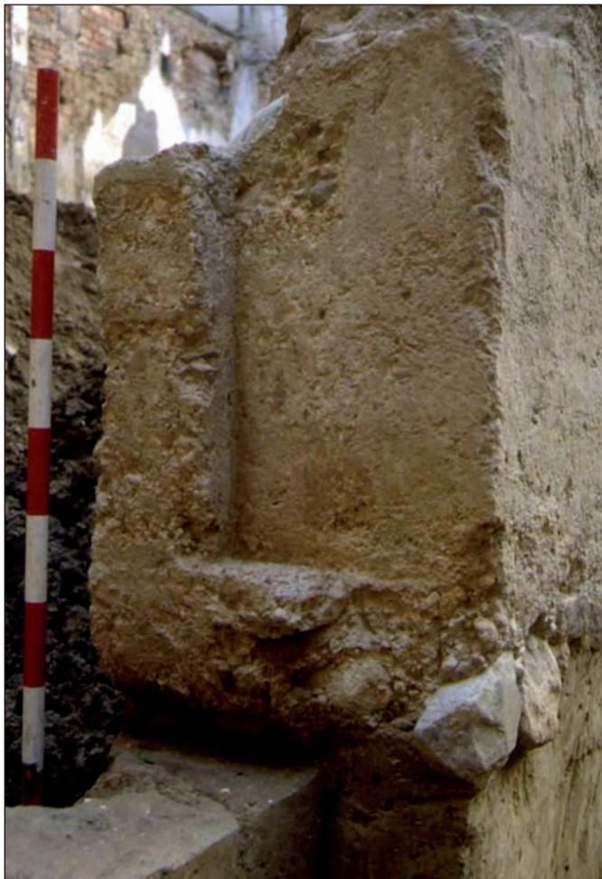
Fig. 17. Casa A de calle Platería de Murcia, nº 14 (s. XII). Detalle de la jamba con la mocheta encofrada en la obra de hormigón
