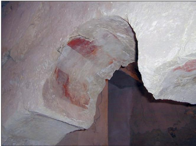
Fig. 12. Detalle del lóbulos central del arco del convento de Nuestra Señora las Huertas de Lorca, donde se observa el dovelaje fingido mediante pintura roja sobre el enlucido
