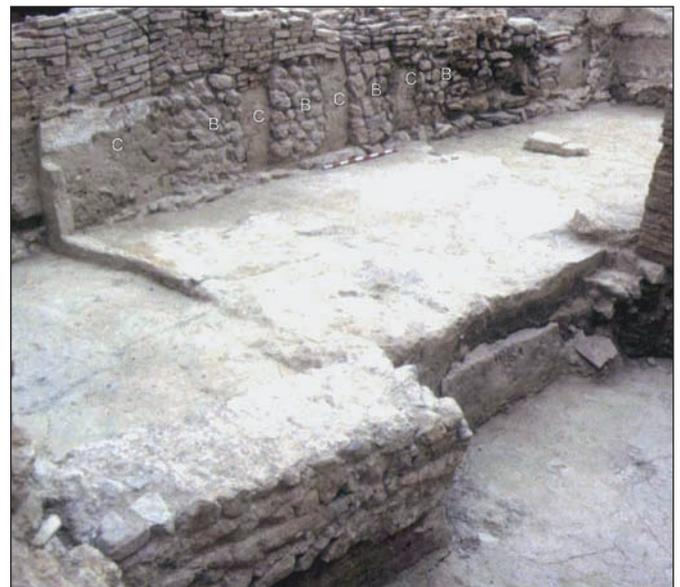
Fig. 9. Casa de plaza Belluga de Murcia (ss. X-XI). Salón norte. Obsérvese en la medianera del fondo las reparaciones realizadas con sucesivos bataches de mampostería (B) que dejan entre sí angostos tramos del alzado original de tierra (C). El basamento de mampostería es casi todo cimentación, pues sólo su hilada de piedras superior está por encima de la cota marcada por el suelo original
