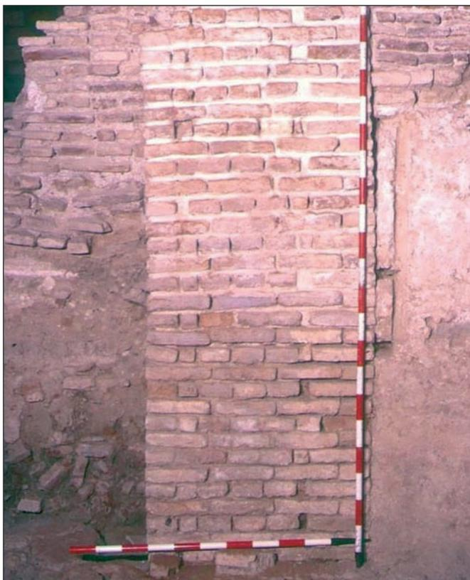
Fig. 39. *Qasr al-Sag'ir*. Segundo cuarto del siglo XIII. Cimentación de ladrillo de la jamba occidental del vano de acceso al salón norte
