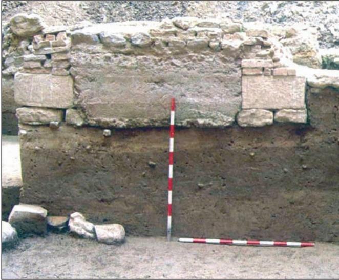
Fig. 14. Casa A de calle Platería de Murcia, nº 14 (s. XII). Muro construido con cimentación de tapial de hormigón y solución mixta en las jambas: cimentación de sillares y alzado de ladrillos
