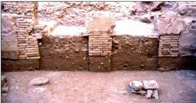
Fig. 15. Casa excavada en el casón de Puxmarina de Murcia (s. XII). Muros construidos con cimentación de tapial de hormigón y jambas y pilar central de un vano geminado fabricados con ladrillo
