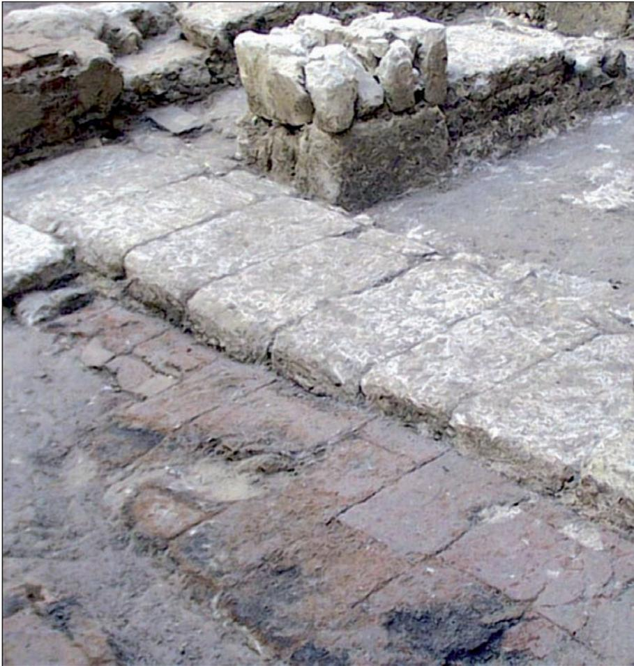
Fig. 5. Casa de calle Organistas de Murcia (ss. X-XI). Detalle del pavimento del andén a base de losas de calcoarenita y de la parte central del patio compuesto por baldosas cerámicas
