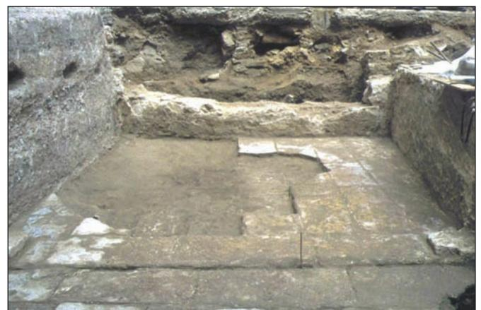
Fig. 21. Baño del Trinquete de Murcia (ss. XII-XIII). Pavimento de losas de piedra de la sala caliente
