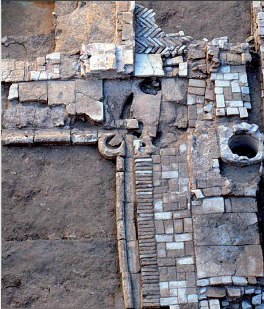
Fig. 20. Casa excavada en un solar de calle Trapería de Murcia (primera mitad del s. XIII). Los umbrales de las puertas que se abrían al patio, el pavimento del tramo de andén que se ve en la parte superior de la foto y el canalillo perimetral del jardín son de piedra, mientras que el tramo del andén de la derecha es una reparación hecha con ladrillos
