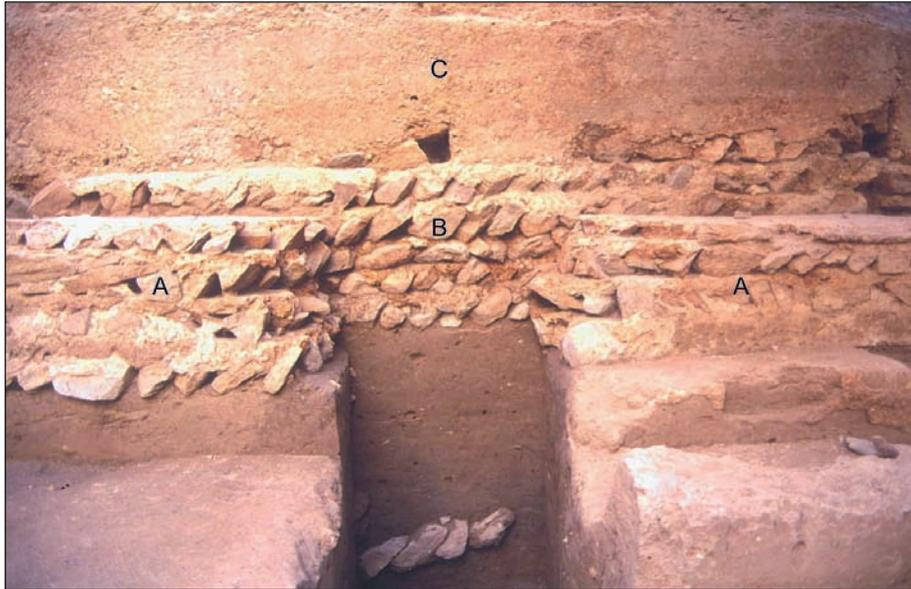
Fig. 1. Casón de Puxmarina (Murcia). Medianería conformada por dos muros adyacentes con cimentación de mampostería (s. X). El proceso de formación es el siguiente:
