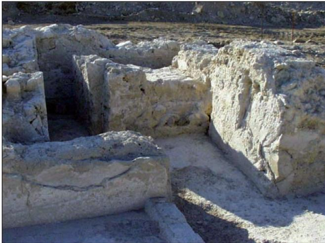
Fig. 44. Mezquita del Centeno (Lorca). Muros de tapial de tierra sobre zócalo de mampostería con yeso en la zona de la escalera
