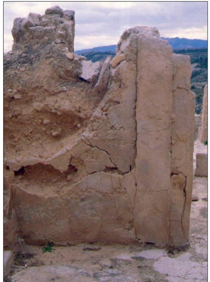
Fig. 41. Siyâsa (Cieza), casa 2. Muro que separaba el salón del patio. Obsérvese la técnica del tapial con breñas, consistente en reforzar con mortero de yeso y piedra la parte de la caja próxima a la jamba mientras que el resto es de tierra
