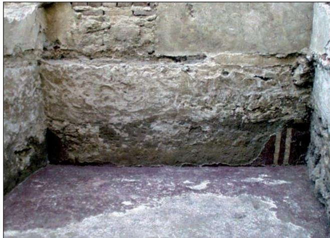
Fig. 18. Casa nº 4 del solar de plaza de Romea, esquina calle Alfaro de Murcia (ss. X-XI). Salón principal norte. Pavimento de argamasa y zócalo, ambos pintados en rojo. En el alzado se conserva un motivo geométrico en reserva compuesto por dos bandas verticales
