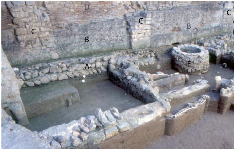
Fig. 24. Casa y cementerio de San Nicolás de Murcia. Los muros de mampostería pertenecen a una vivienda (A) que posteriormente fue convertida en cementerio. La obra de tapial de hormigón (B) y los refuerzos de sillares reutilizados (C) pertenecen a la fase del cementerio. La obra de ladrillo (D) es una reparación del alzado original de tierra que debió tener la cerca del cementerio. El pozo (E) es una infraestructura postmedieval
