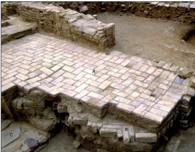
Fig. 25. Casa andalusí de calle Cortés de Murcia. Pavimento del patio. Existen tres solerías: la más reciente está compuesta por ladrillos a tabla en espiga, contorneada por una banda perimetral (A); la intermedia dispone los ladrillos a sardinel en espiga (B); la más antigua son losas de piedra (C)
