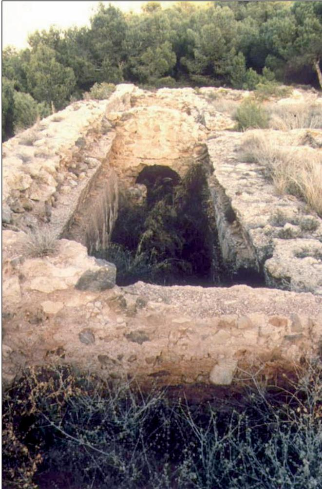
Fig. 36. Recinto superior del Portazgo (Murcia). Tercer cuarto del siglo XII. Obsérvese en la parte superior de la obra de hormigón el retalle para apoyar la bóveda de ladrillo que debía cubrir la cruja
