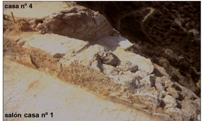
Fig. 40. Siyâsa (Cieza), casa 1. Zócalo de tapial de mampostería con yeso sobre el que se disponía el alzado de tierra. Apréciase la huella de un mechinal del encofrado de la caja superior desaparecida
