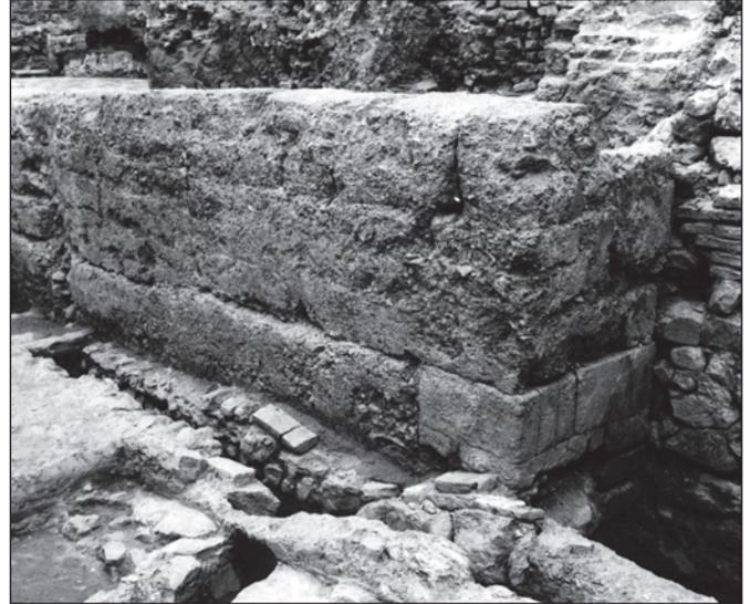
Fig. 16. Casa excavada en el solar del casón de Puxmarina de Murcia (ss. XII-XIII). Véase en el muro de tapial de hormigón cómo ha sido reforzada su esquina con sillares de calcaenita
