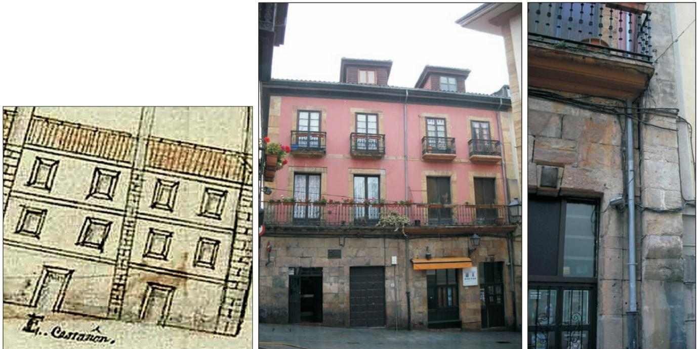
Fig. 30. Casas de Pintado y Castañón en su estado actual y casa de Castañón en el plano de 1738, con la vivienda desaparecida en su flanco derecho. A la derecha, detalle del cortafuegos original con ménsulas
