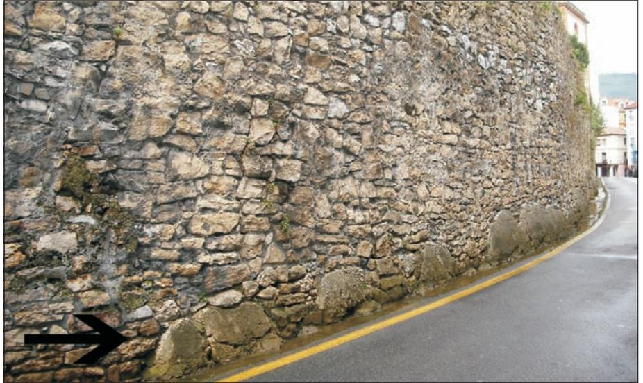
Fig.7. Merlones , fábrica mixta de mampuestos concertados colocados en hiladas y banqueta de dos hiladas de sillares sobre «peñas». Estas peñas se observan en la muralla del Paraíso (foto inferior)
