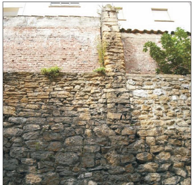
Fig. 16. Vestigio de un muro cortafuegos con remate pinacular, como los que se representan en el plano de 1738. Formaba parte de uno de los desaparecidos edificios que amortizan la muralla medieval en la calle del Paraíso
