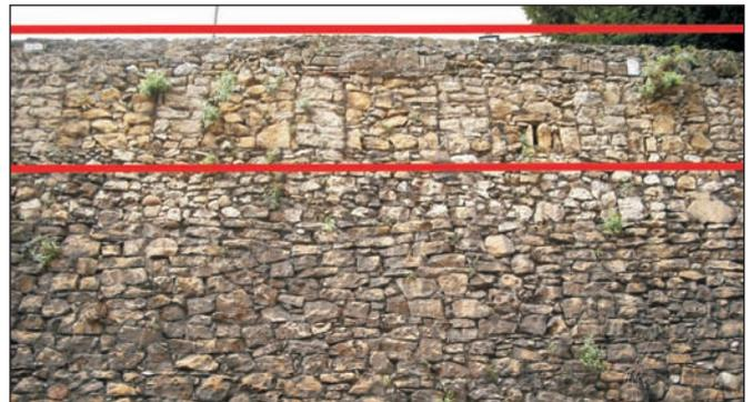
Fig. 5. Merlones, con las almenas ya cegadas, en el tramo de muralla de la calle Paraíso
