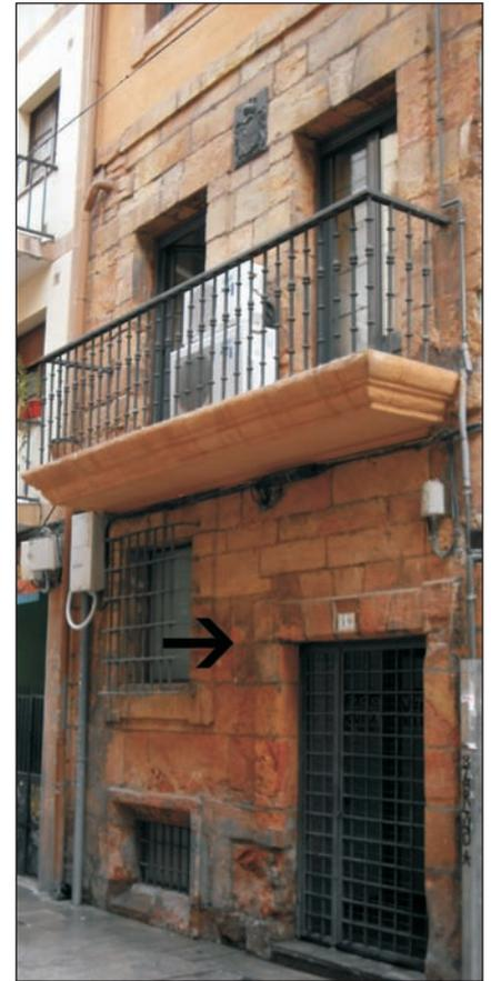
Fig. 25. Módulo original de la casa y dintel de orejeras señalado por la flecha
