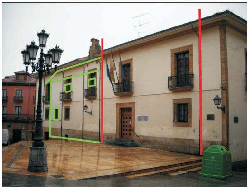
Fig. 33. Palacio de Inclán y casa de Faes en 1738 y tras la reforma del palacio. En rojo, el límite del inmueble original de los Inclán y en verde, la proyección de la casa de Faes que existía antes de la reconstrucción
