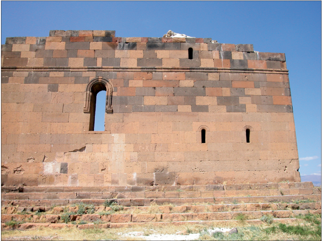
Fig. 7. Parete absidale esterna, porzione nord, da est (Foto N. Montecchi)
