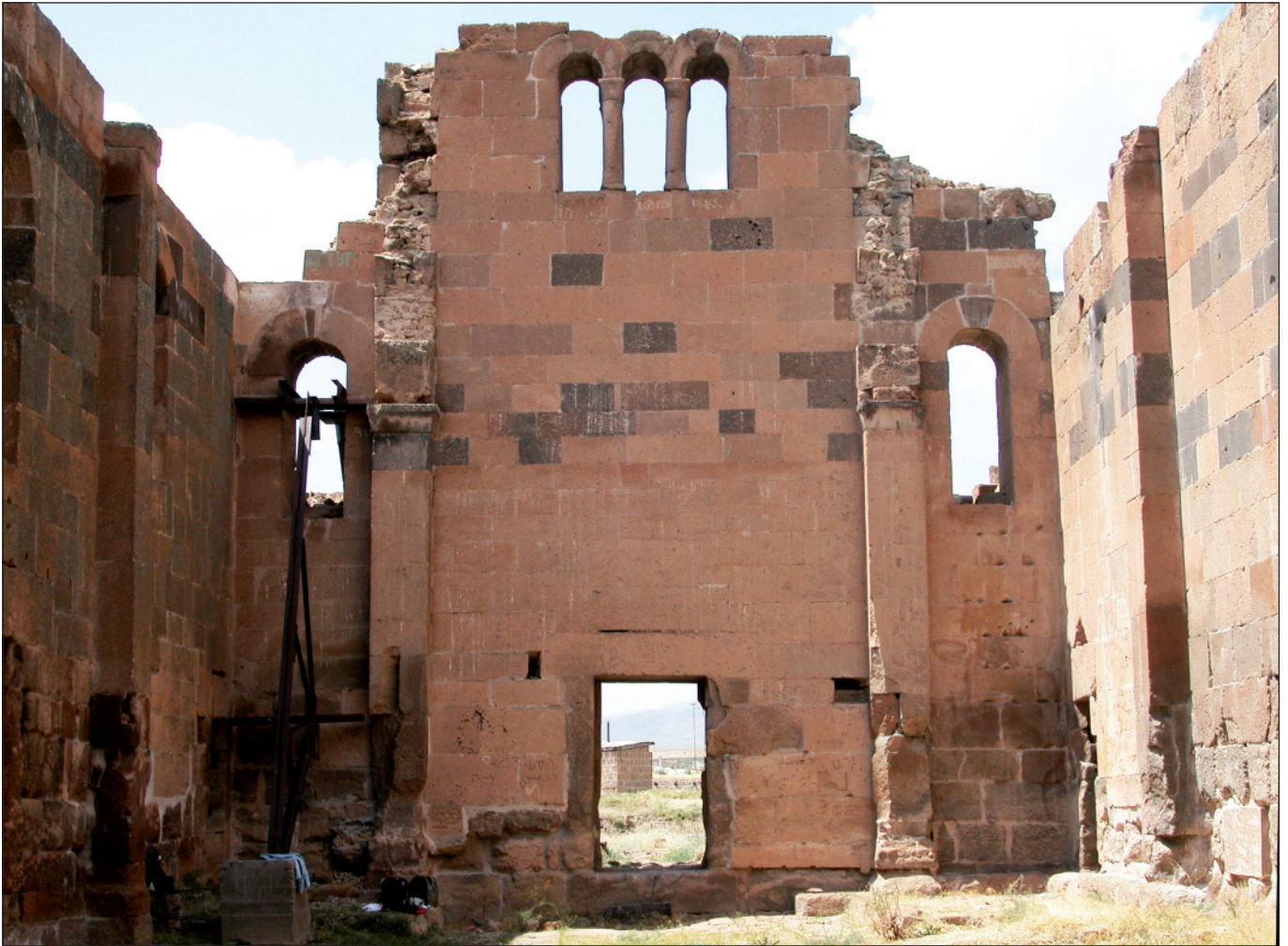
Fig. 11. Facciata ovest, interno, da est (Foto N. Montevocchi)
