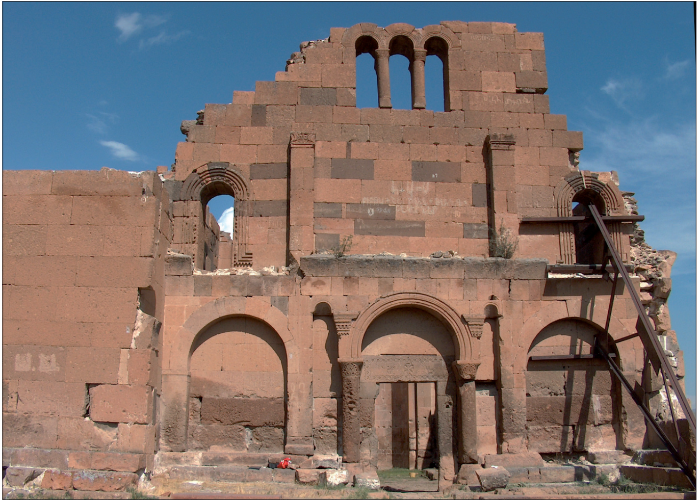
Fig. 9. Facciata ovest, da ovest (Foto C. Tonghini)
