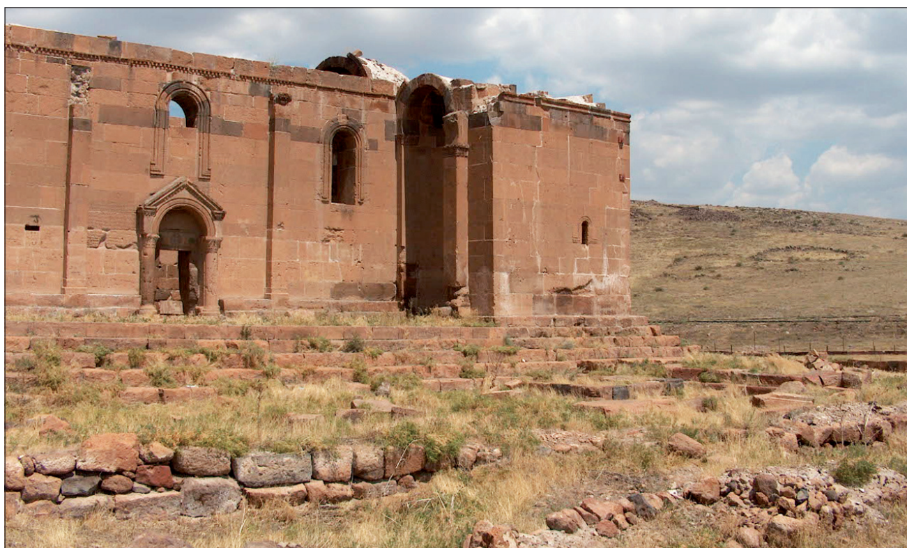
Fig. 13. Facciata sud, porzione est, da sud-ovest (Foto C. Tonghini)
