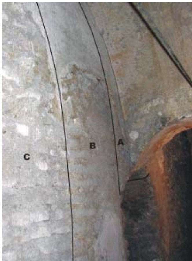
Fig. 12. Interpretación de las distintas fases en el pórtico oriental del jardín: A.- fábrica islámica, B.- Fábrica gótica, C.- fábrica del siglo XVIII que tapia la arquería.
