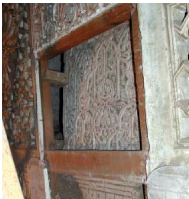
Fig. 8. La decoración original del paramento oeste con el recubrimiento de placas de escayola.
