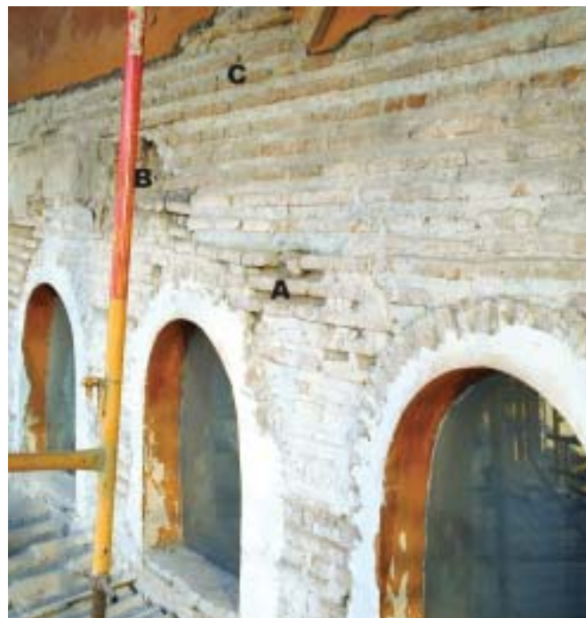
Fig. 7. Muro de la linterna de la qubba con sus distintas fábricas y fases. A.- fábrica de ladrillo nazari, B.- restos del cajón de tapia nazari, C.- Fabrica de ladrillo de la refacción moderna.
