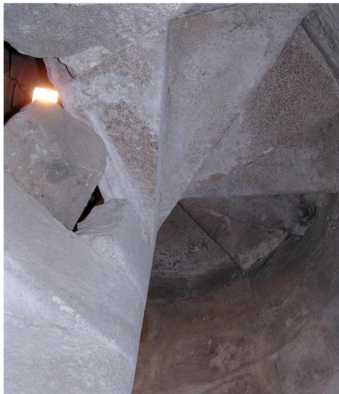
Figura 16. Escalera de caracol de interior de la torre del esquinual sur conservado de la iglesia románica, con algunos peldaños en mal estado. En algunos sillares del eje central de la escalera todavía se pueden reconocer marcas de cantería similares a las existentes en la cara exterior de los muros románicos conservados. (Fotografía de la autora)
