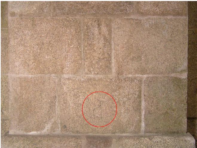
Figura 4. Marca de cantería (P) tallada en uno de los sillares del contrafuerte románico (Fotografía de la autora)
