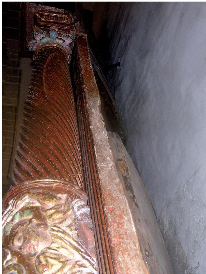
Figura 20. Parte posterior del retablo de San Benito con una forma preparada para ser encajado en un ábside curvo (Fotografía de la autora)
