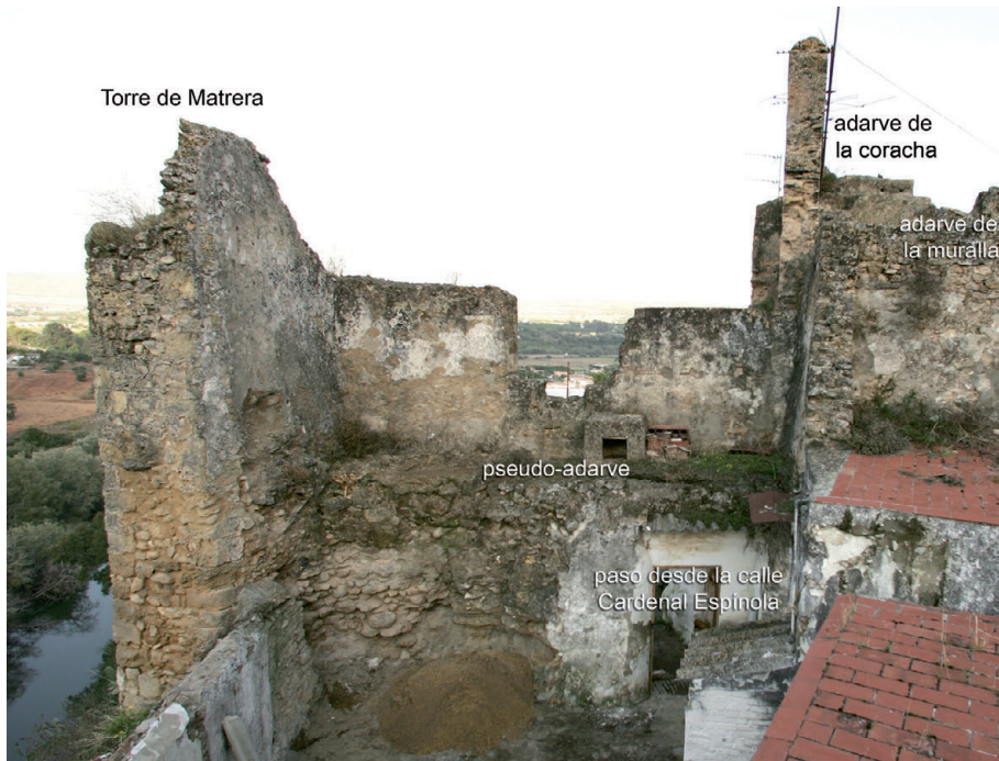
Fig. 7. Zona 2. Estructuras conservadas en el extremo septentrional de la muralla sureste de Arcos de la Frontera (sector 1, muro A). Vista desde la terraza de la vivienda situada en la calle Matrera Arriba nº 5
