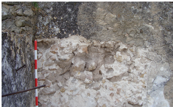
Fig. 10. Zona 2. Alma de la muralla, consolidada por revoco de cal y trozos de ladrillo, apreciable en el extremo sur del pseudo-adarve existente en la calle Matrera Arriba nº 5 (sector 1, muro B)
