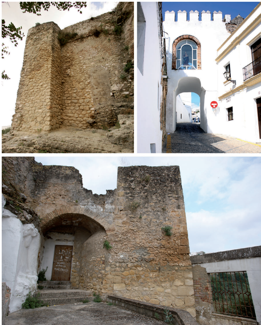
Fig. 3. Puerta del Cómpea (arriba izquierda), Arco de Matrera visto desde la calle Matrera Abajo (arriba derecha) y paso sobre la muralla existente en la calle Cardenal Espínola, flanqueado por la Torre de Matrera (abajo)
