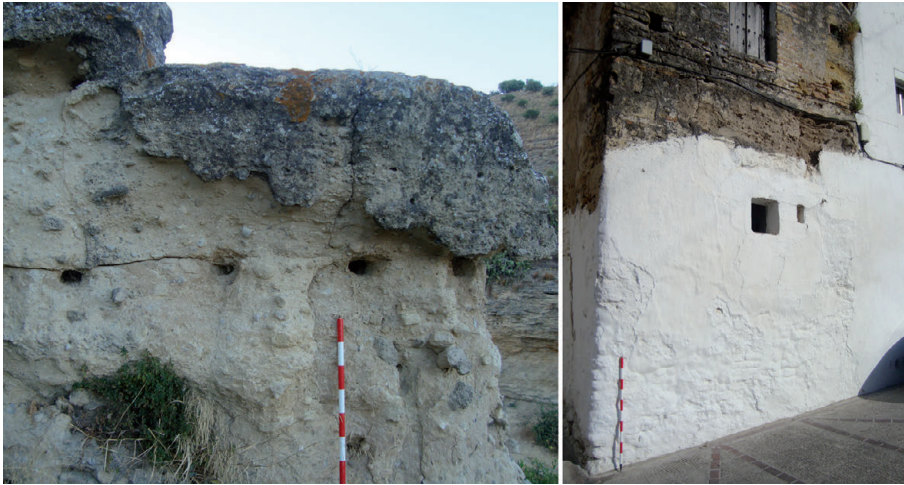
Fig. 20. Restos de la torre albarrana de San Antón (izquierda) y de la torre situada en la calle Juego de Padilla (derecha)
