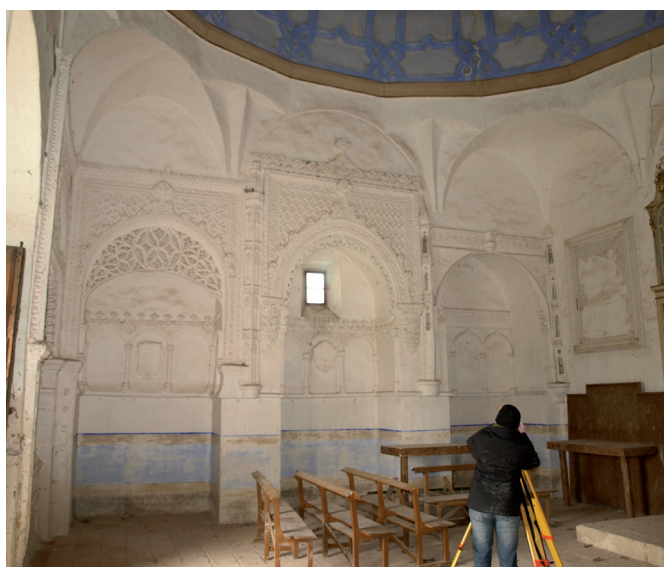
Figura 26. Vista interior de la capilla de la Mejorada (Olmedo).
