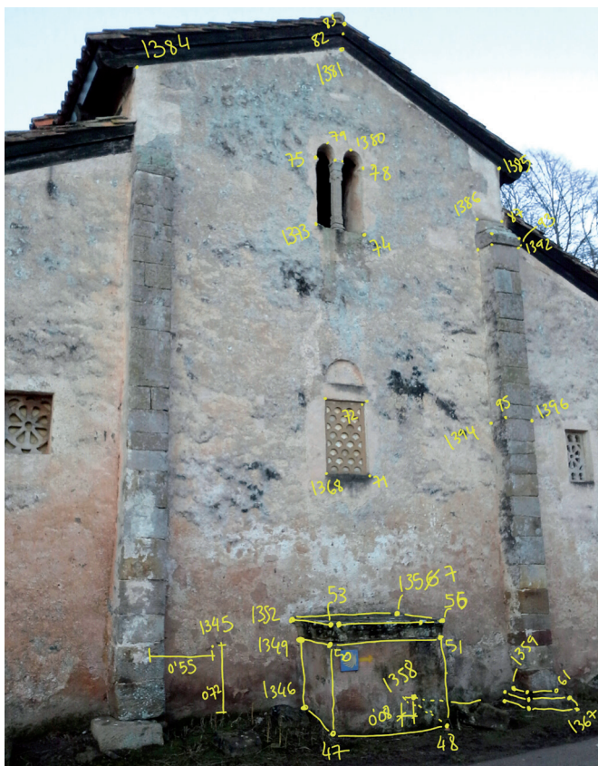
Figura 5. Croquis de campo con puntos medidos en la iglesia de San Salvador (Priesca).
