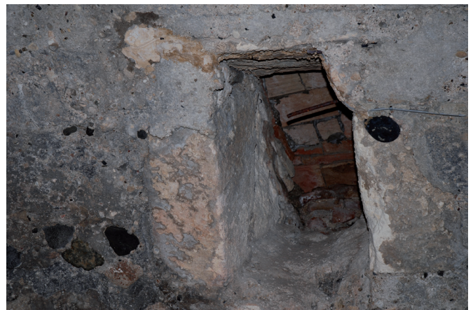
Figura 15. Detalle de la abertura a gola di lupo visible en el ámbito 8
