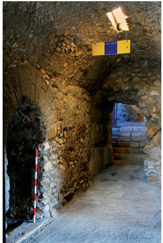
Figura 11. Detalle de las puertas 3 (izq.) y 1 (fondo). Esta última tapiada (fase III) y reabierto parcialmente
