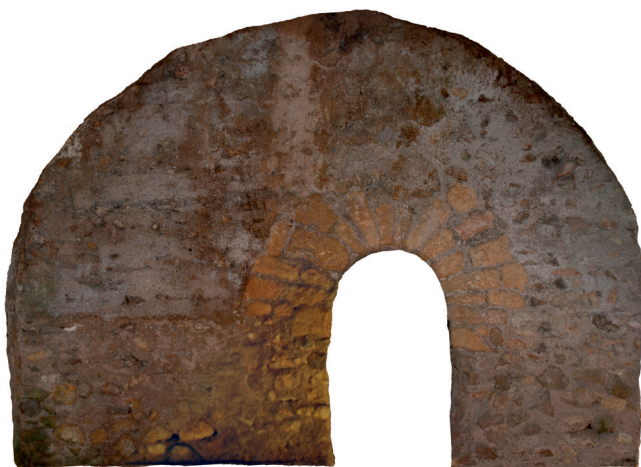
Figura 10. Detalle de la puerta de acceso al ámbito 2
