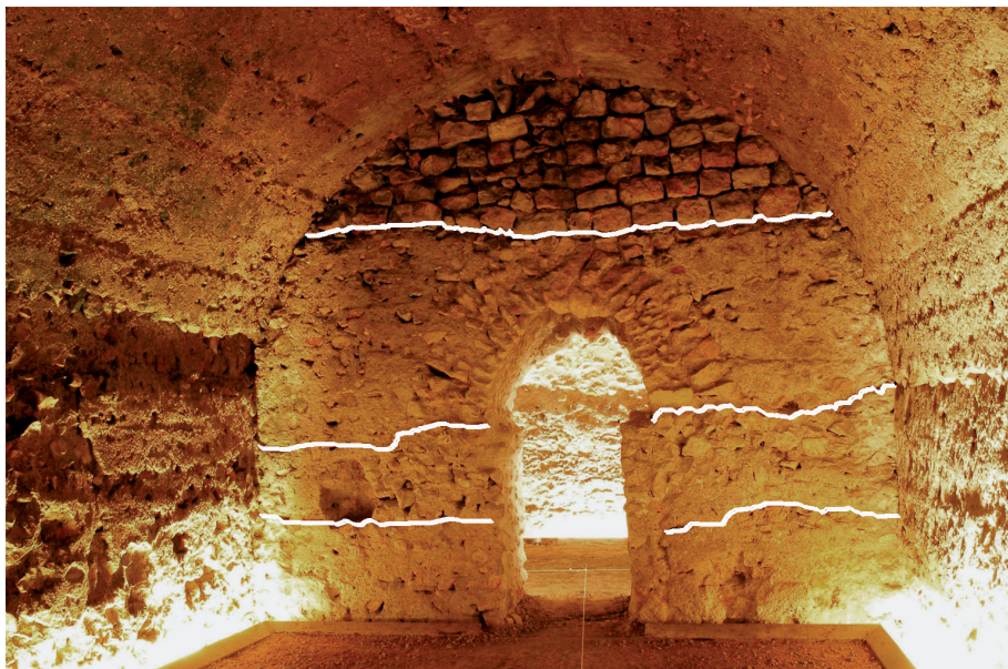
Figura 12. Detalle interior del ámbito 5 delimitando los tramos del proceso de construcción
