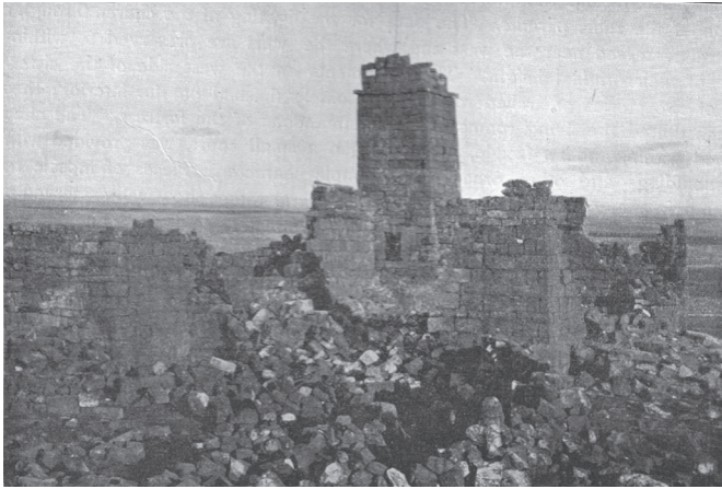
Fig. 31. La chiesa del monastero di san Giorgio a Samā vista da sud-ovest (Butler 1909: 84, ill. 64), dove è ancora possibile osservare la parte alta della torre con la cornice aggettante
