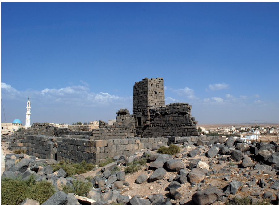
Fig. 30. La chiesa del monastero di san Giorgio a Samā con la torre-minareto vista da sud-ovest
