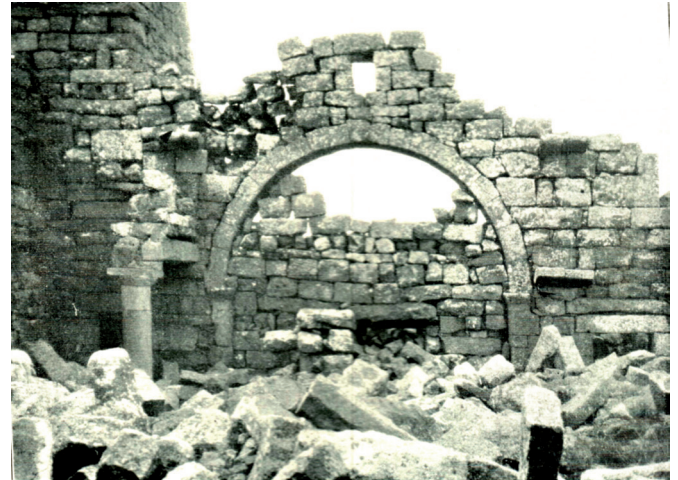
Fig. 4. Scatto fotografico di H.C. Butler del 1904-1905. L'immagine raffigura l'abside tamponato ed una colonna ancora in situ . L'interno era completamente occupato dal crollo dell'edificio (Butler 1909: ill.79)
