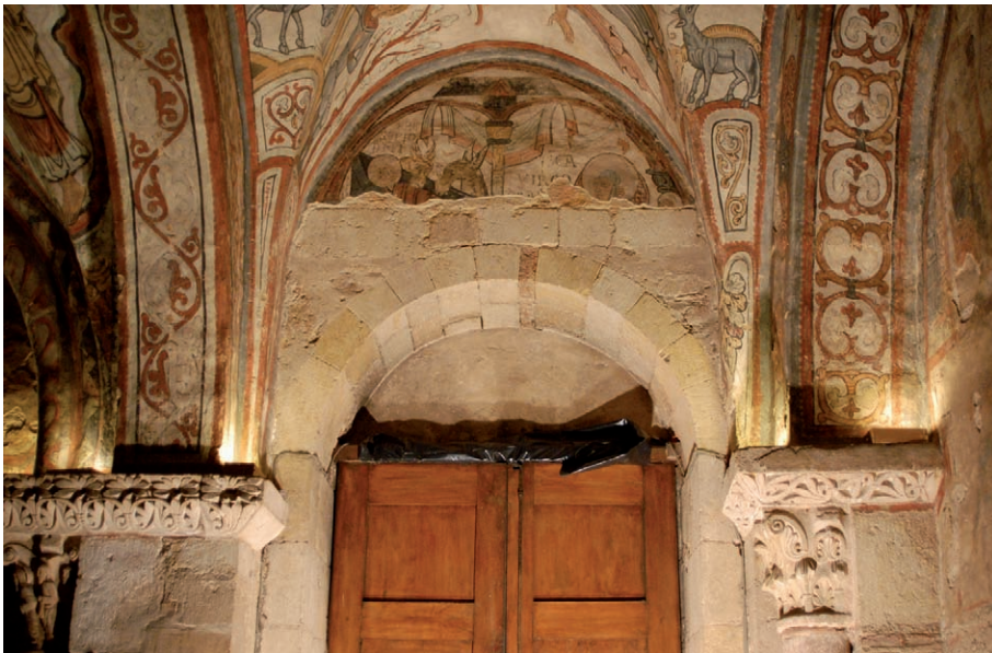
Fig. 26. Detalle de las pinturas del panteón [UE 1325, A 200] y la apertura de la nueva puerta [UE 1225, A 105], observándose cómo un estrecho filo de pintura pasa en el ángulo norte (izquierda) sobre los sillares del tímpano
