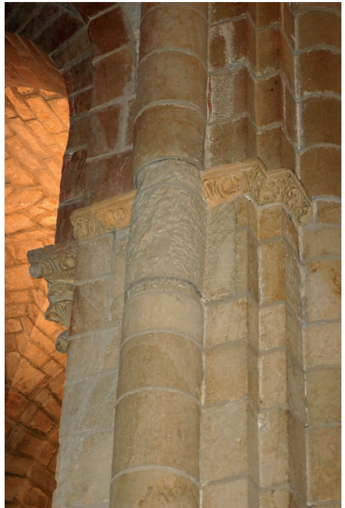
Fig. 35. Capitel sur inferior picado [UE 1272, A 175] entre molduras restauradas [UE 1271, A 178]
