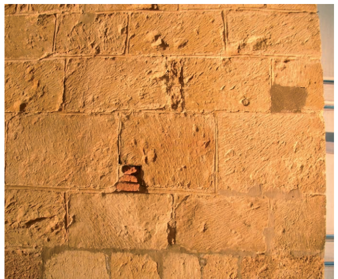
Fig. 11. Detalle de la fábrica del Periodo I, jamba occidental del vano norte [UE 1071, A 101]
