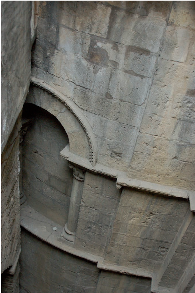
Fig. 34. Exterior del ábside septentrional, detalle del tramo norte al cual se adosa la Capilla de la Santísima Trinidad [UE 1078, A 102]
