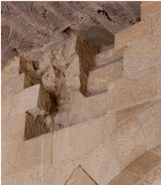
Fig. 7. Restos del escalonamiento del muro norte [UE 1071, A 101] visibles en el exterior del primer tramo occidental detrás de los arcos restaurados por L. Menéndez Pidal
