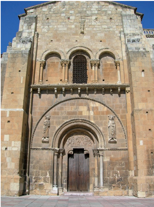
Fig. 31. Fachada meridional del transepto con la Puerta del Perdón [A 102] y serie de mechinales correspondientes a los apuntalamientos de la ruina [UE 1001, A 126]
