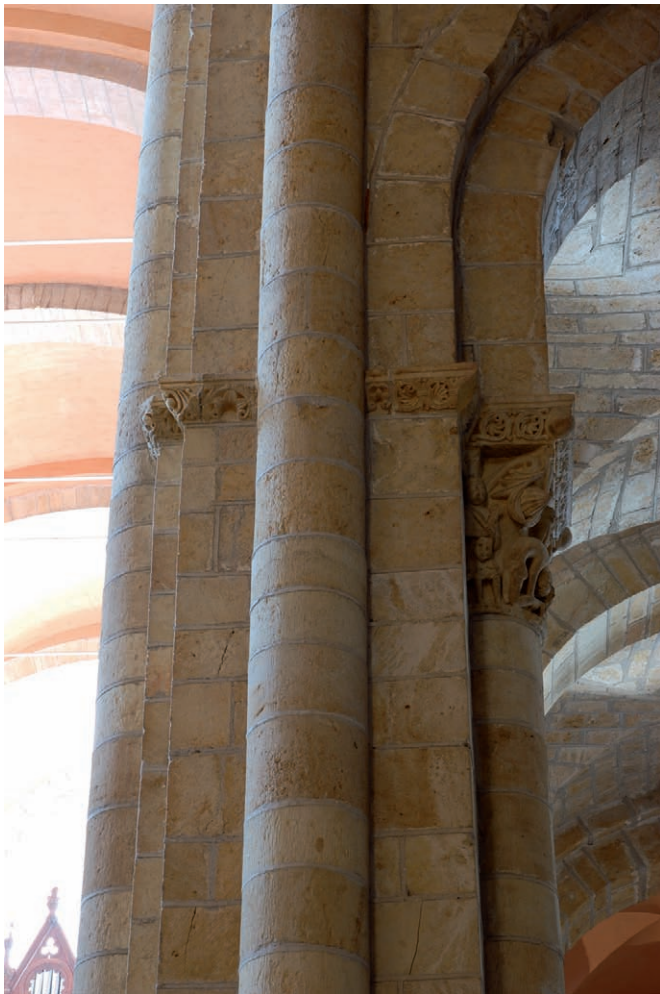
Fig. 37. Punto donde debería ubicarse el capitel norte [UE 1077, A 102] si la arquería continuase hacia el este
