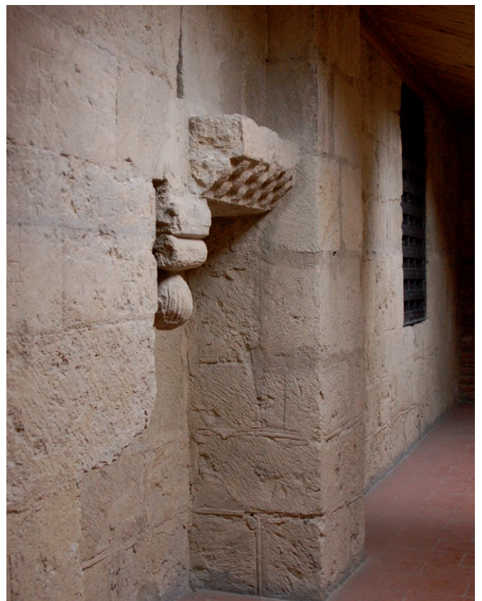
Fig. 13. Modillón e imposta de la nave norte [UE 1290, A 101] y superposición del muro románico (Periodo II: UE 1292, A 106) sobre él
