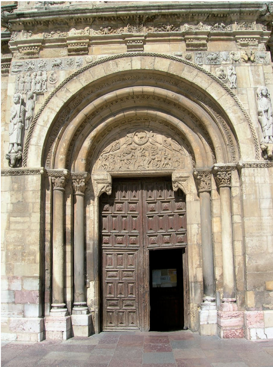
Fig. 44. Portada del Cordero, acceso principal de la nave sur [UE 1038, A 107]
