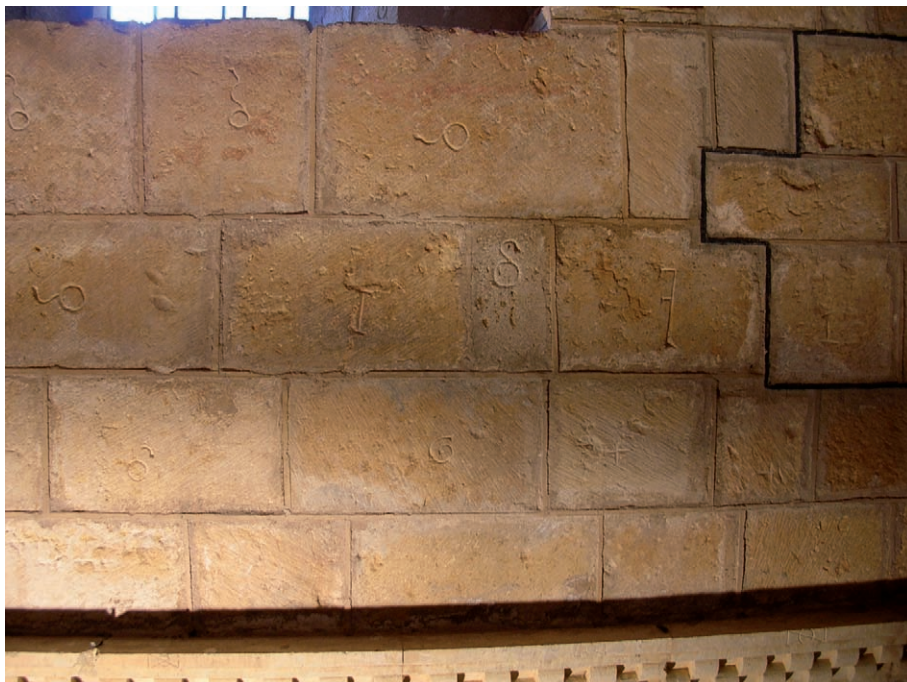
Fig. 43. Detalle de la fábrica del Periodo IIc en el ángulo occidental del muro sur [UE 1034, A 106], entre el alfeizar de la ventana y la imposta baja, con abundantes marcas de cantero
