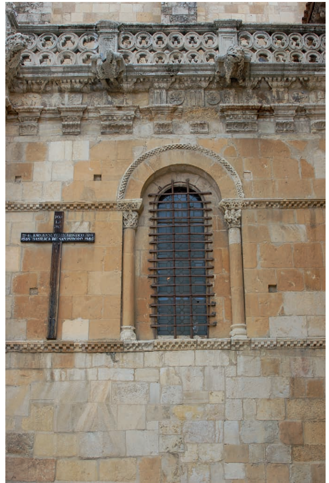
Fig. 29. Paramento exterior del muro sur [UE 1359, A 168], aplacado en parte inferior [UE 1026, A 120] y mechinales de los apuntalamientos de la ruina [UE 1001, A 126] en la superior
