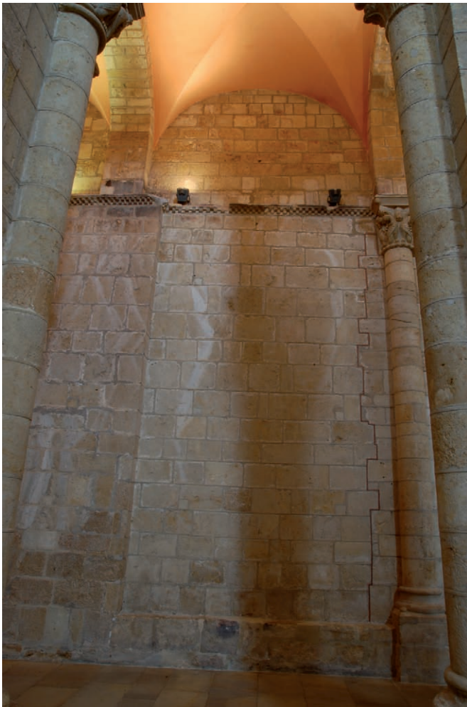
Fig. 28. Lienzo interior de la nave norte [UE 1075, A 169] con los mechinales pasantes y solución de continuidad [UE 1074, A 102] en el tercer tramo
