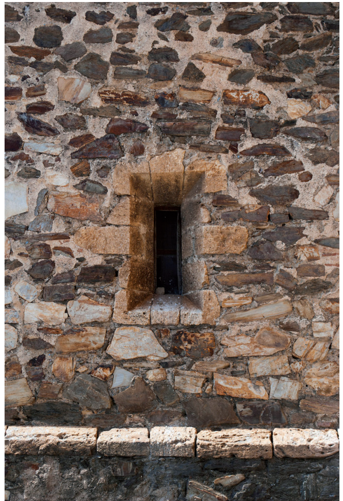
Fig. 11: Sillería. Ventana y biseles de Bayárcal.
