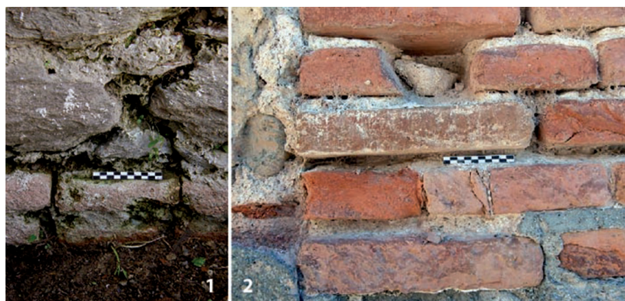
Fig. 14: Ladrillo: 1 – Capilerilla. 2 – Yátor (portada lateral).
