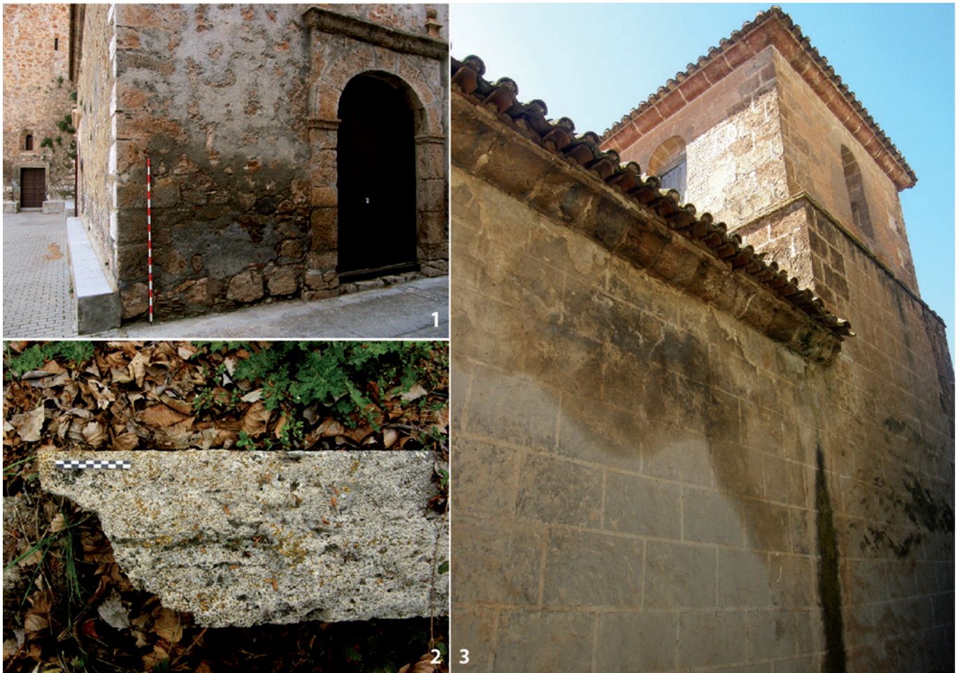
Fig. 10: Sillería. Aristones y cornisas: 1 – Aristones y portada de cantería de Juviles. 2 – Cornisa de perfil de gola reutilizada en la era de Capilerilla. 3 – Cornisa de Tímar.
