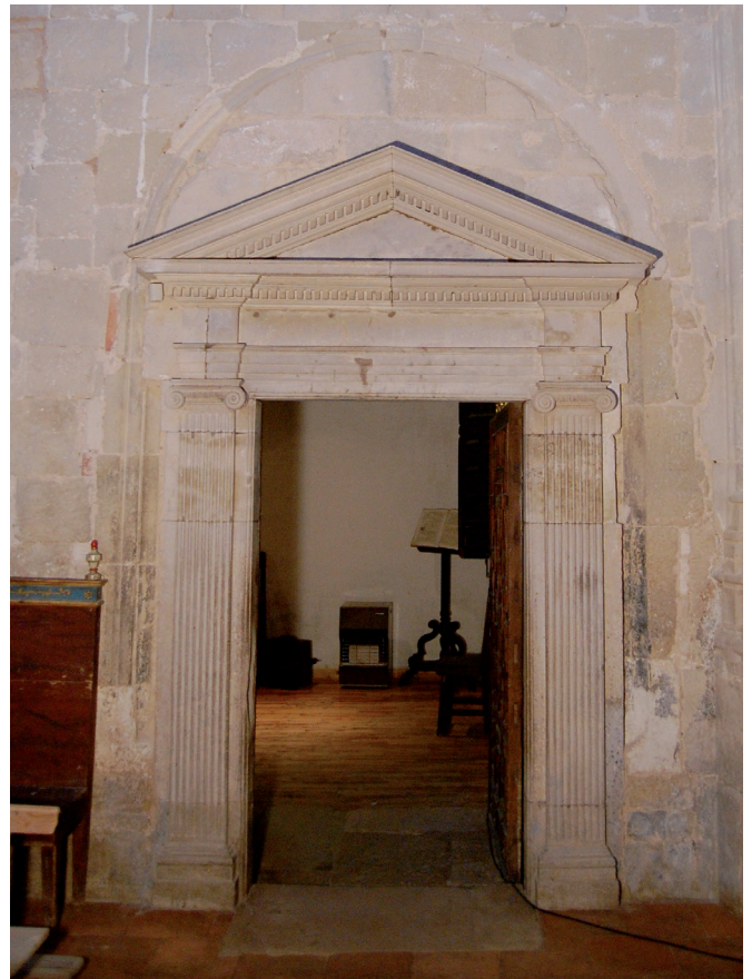
Fig. 16. Puerta de acceso a la sacristía desde el interior del aula
