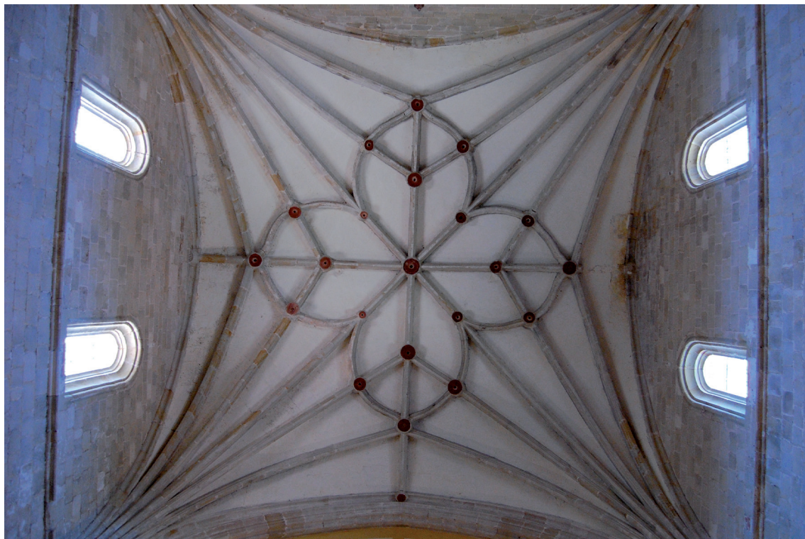
Fig. 12. Bóveda compuesta de arcos cruceros y terceletes en Capilla Mayor
