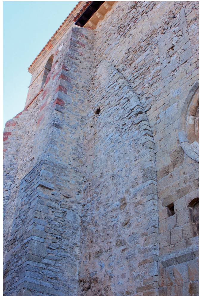
Fig. 15. Estructura con remate convexo en el hastial occidental de la iglesia. Etapa VII
