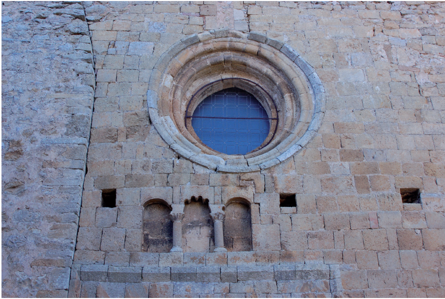
Fig. 7. Óculo en fachada occidental
