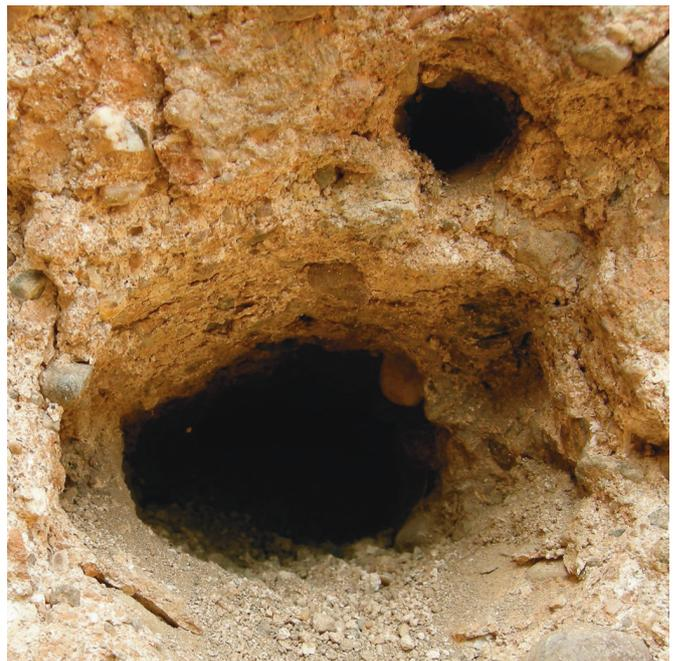
Fig. 13. Marca de una cuerda que asciende sobre el mechnal (Muralla de Sevilla, tramo de la Macarena).
