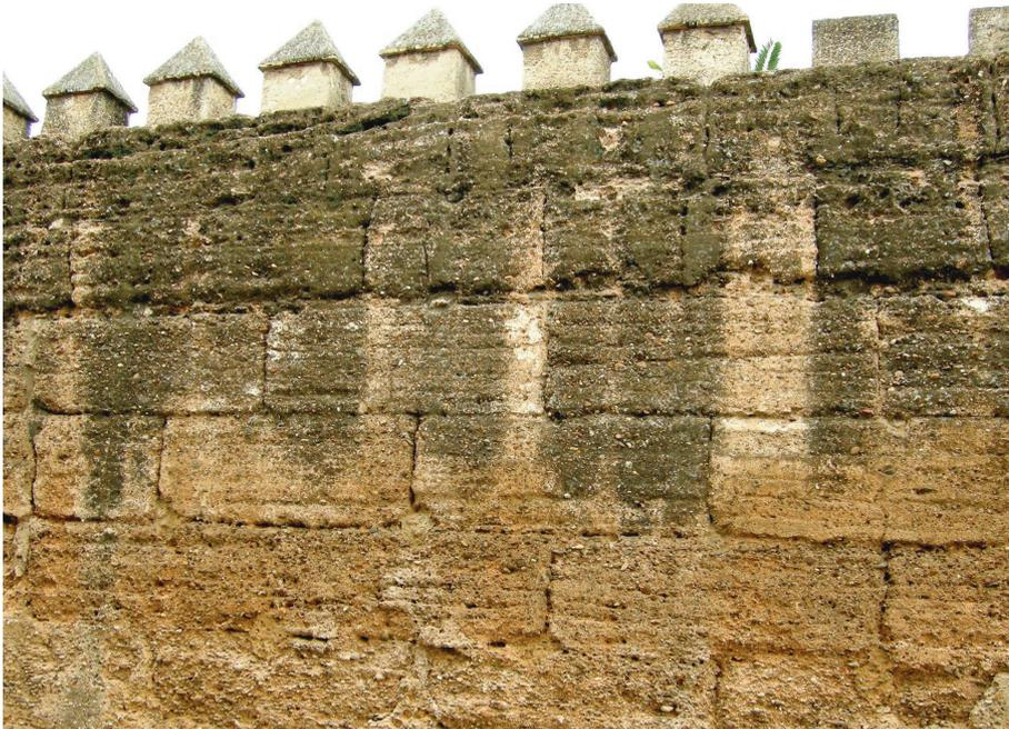
Fig. 9. Lienzo construido mediante cajones independientes, mostrando las juntas verticales (Muralla de Sevilla).
