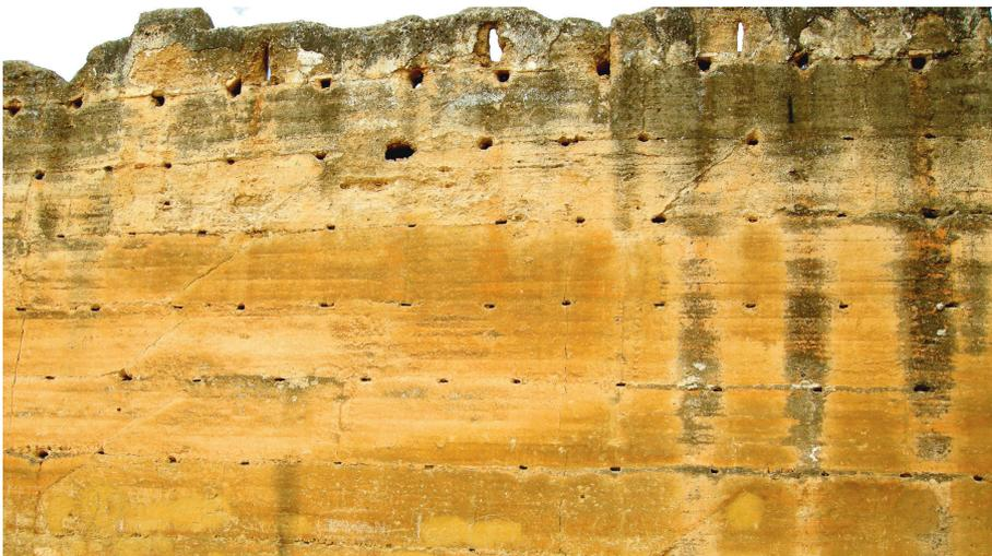
Fig. 10. Lienzo construido con cajones corridos y muestra las típicas juntas inclinadas (Castillo de Alcalá de Guadaíra).
