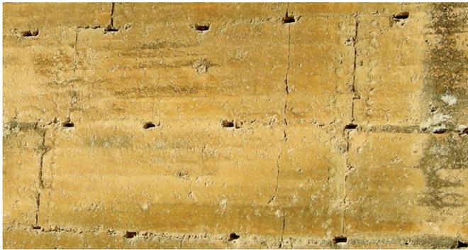
Fig. 16. Huellas de los encofrados sobre el lienzo (Castillo de Alcalá de Guadaíra).
