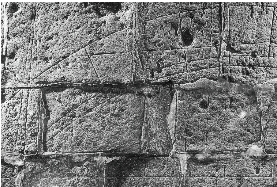
Figura 21. Fotografía de una de las monteas de la iglesia de Santa Clara de Santiago.
