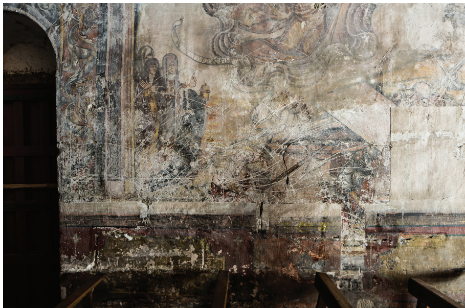
Figura 18. Fotografía de las monteas y pinturas del muro sur de la iglesia parroquial de Nogueira do Miño.
