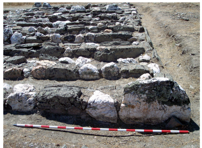
Figura 5. Detalle del aparejo de los muros fabricados con cuarzo y cantos rodados del horreum de la villa romana de Monroy (Extremadura). Fotografía: autor.
