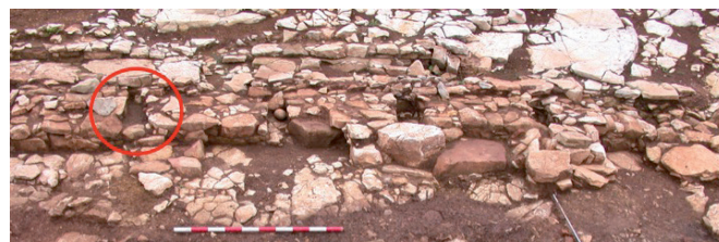
Figura 7. Aberturas de ventilación del muro norte del granero de Veranes (Asturias) con indicación de una que presenta un mayor abocinamiento. Imagen: Fernández Ochoa y Gil Sendino.
