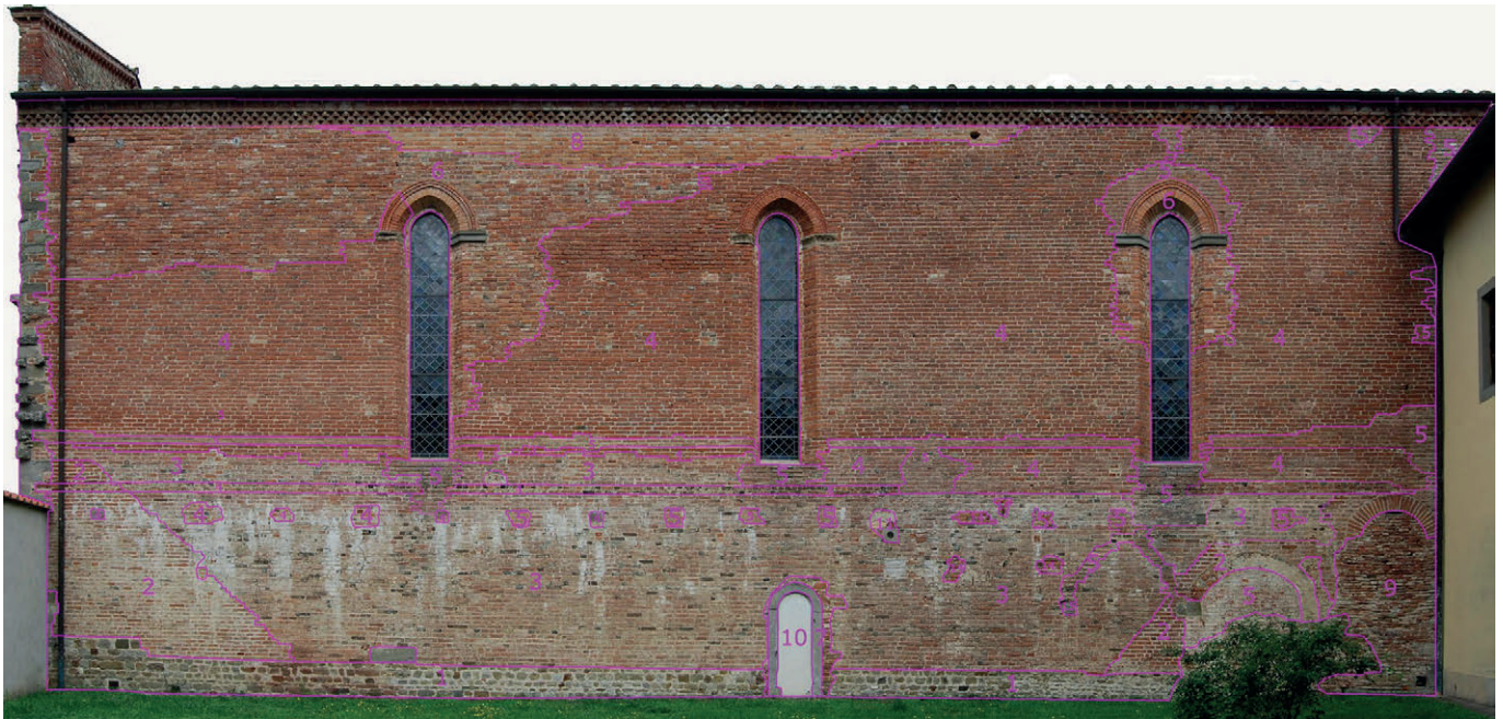
Fig. 1. L'immagine mostra una esemplificazione della lettura stratigrafica operata per gruppi di attività costruttive. In particolare la figura presenta l'analisi stratigrafica del prospetto sud della chiesa di San Francesco a Borgo San Lorenzo (FI).
