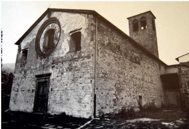
Fig. 12. La Pieve di San Gavino Adimari mostra ancora oggi caratteri cinquecenteschi e settecenteschi relativi ai due grandi restauri che hanno interessato la struttura in epoca moderna. (Campidori 1980: 100)
