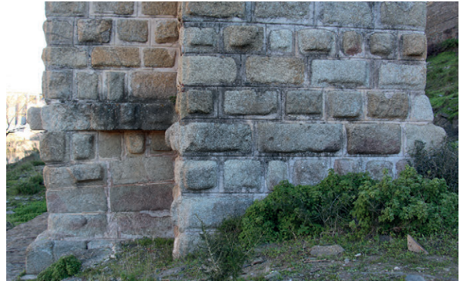
Fig. 7a. Paramento aguas abajo con la presencia de tres hiladas de arco relativas a la estructura anterior al puente de época de Trajano.
