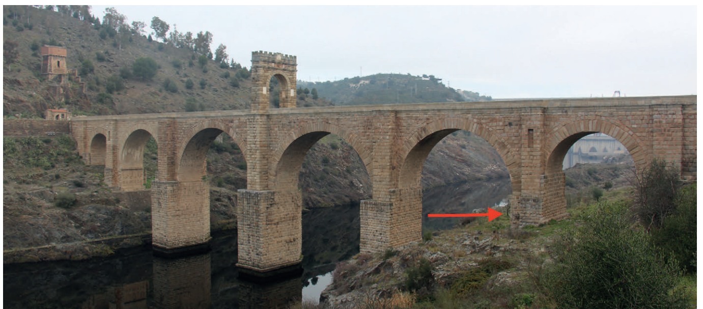
Fig. 5. Vista general del puente con indicación de la pila analizada y presencia de una estructura anterior al puente de época de Trajano.
