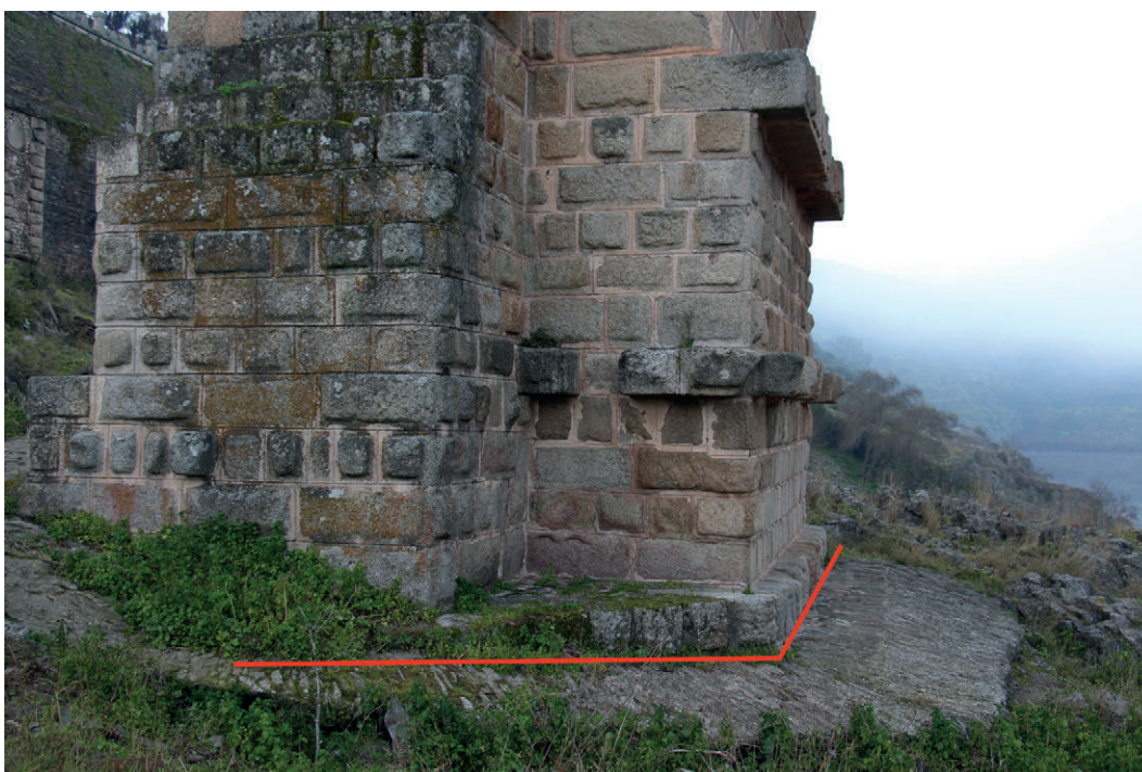
Fig. 9. Restos del primer proyecto de un tajamar triangular bajo la estructura anterior al puente de época de Trajano.
