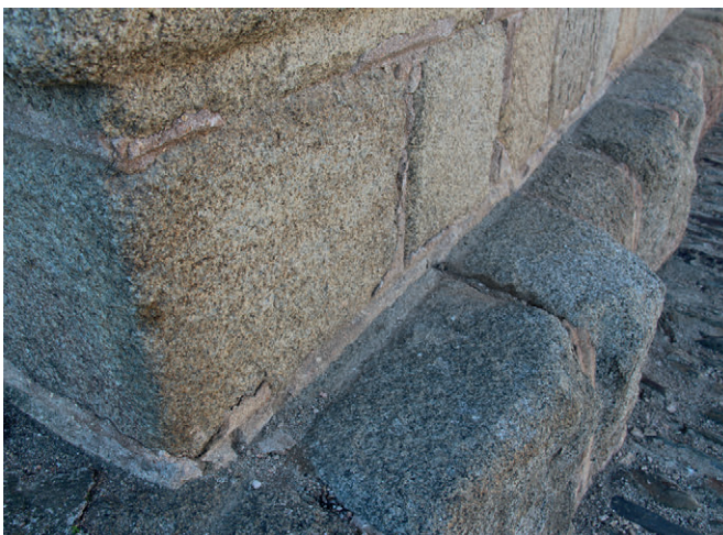
Fig. 11. Detalle de la línea de monte para la edificación de la estructura perteneciente a la primera fase.
