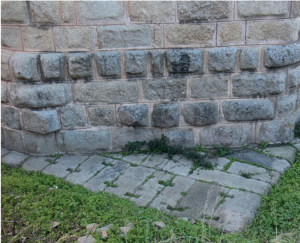
Fig. 10. Plataforma de cimentación de la pila 3 con sillares de granito unidos con grapas de cola de milano.
