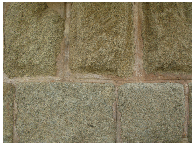
Fig. 13. Punto de contacto entre las dos fases de construcción del puente con evidencia de la diferencia del tipo de granito empleado.
