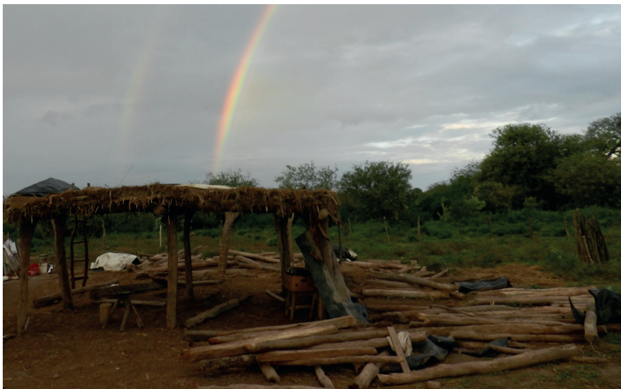
Fig. 5. Reutilización de espacio y materiales. Nueva habitación en proceso de construcción a partir del reuso de troncos procedentes del desarme de la estructura de palo a pique ilustrada en la figura 2 que ocupaba el área inmediata contigua (Familia Silva). Fotografía de la autora.
