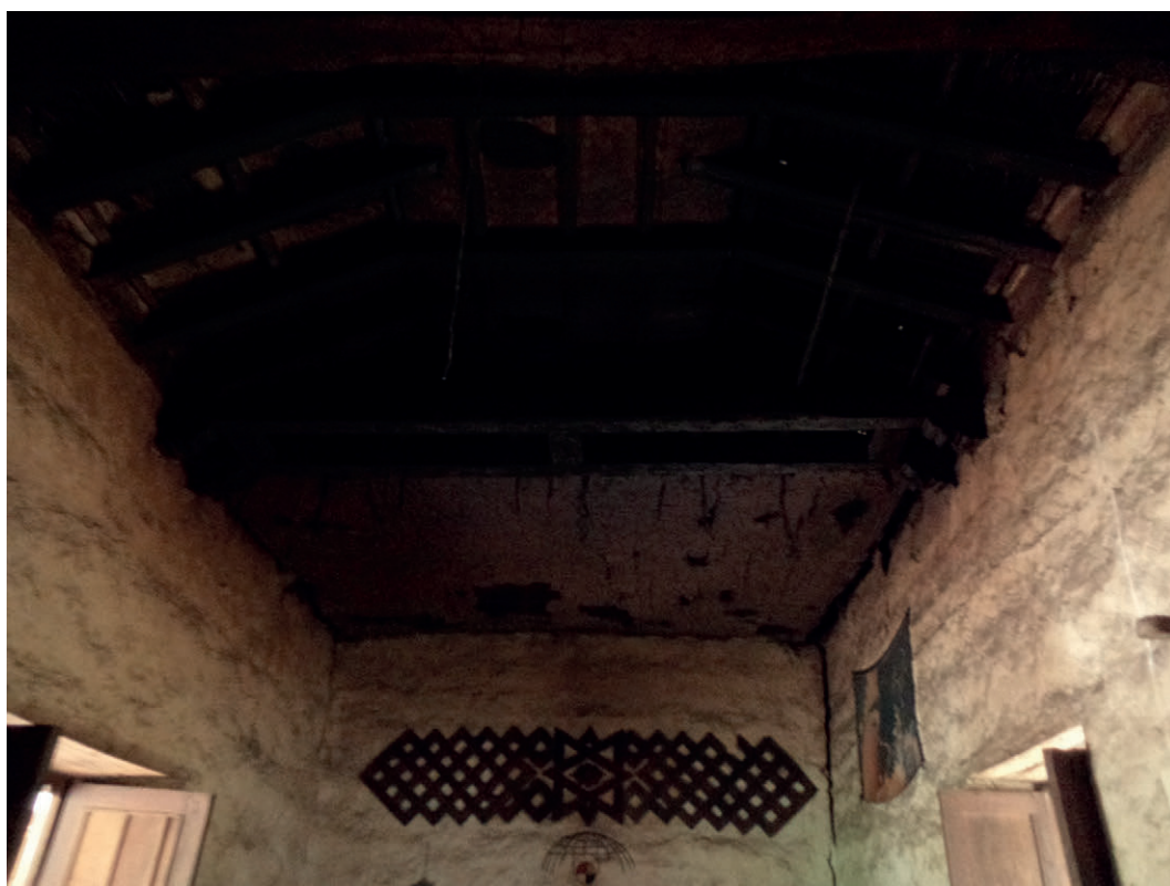
Figura 10. Vista interior de la estructura de cubierta. (Fotografía: Aguirre 2016)
