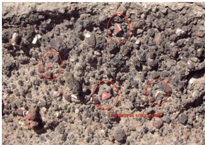
Figura 7.- Muestra fragmentos de estucos de edificios demolidos formando parte de los aplanados. Muro perimetral del Templo de Barrio de La Ventilla. Foto Jaime Delgado Rubio.
