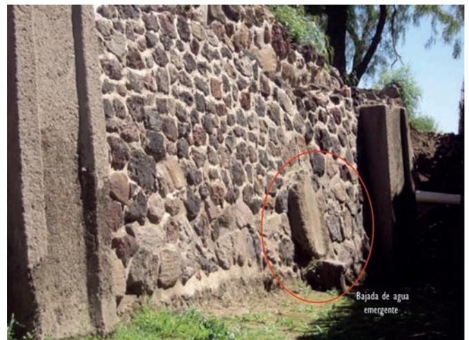
Figura 5.- Muestra una bajada de agua planificada con la construcción (primer plano) y una segunda (señalada en círculo rojo) construida de forma emergente. Foto Jaime Delgado Rubio.
