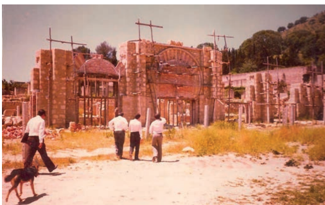
Figs. 18a y 18b Visita de obra [aparecen perros de vigilancia del recinto] (ARM).
