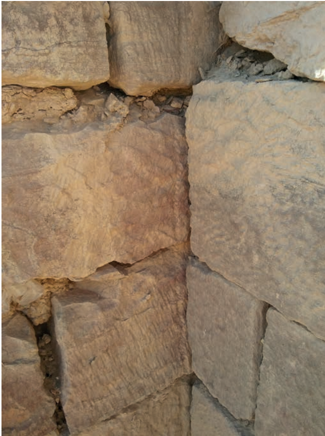
Figura 15. Encuentro entre el muro lateral sur y el muro exterior del patio de QH36.
