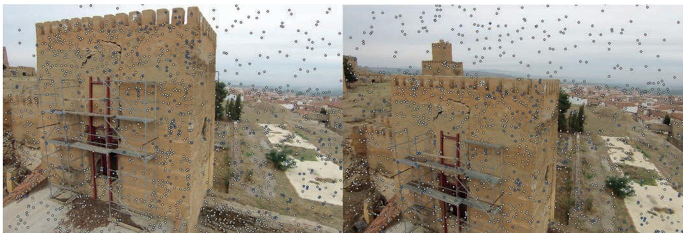
Figura 7. Correlación de dos imágenes del alzado sur de la torre-puerta a partir de puntos invariables de enlace radiométrico.
