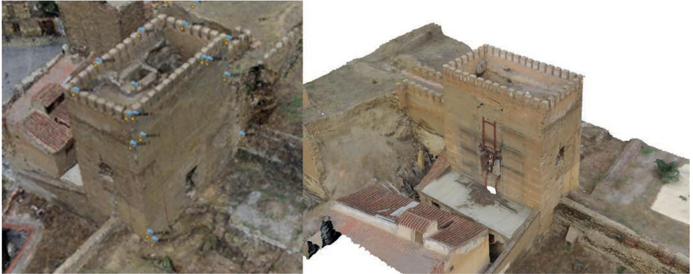
Figura 8. Modelo tridimensional mediante nube de puntos de la vista noreste de la torre-puerta obtenida por intersección múltiple de haces proyectivos (izq.). Vista sureste del modelo tridimensional de superficie texturizado (dcha.).
