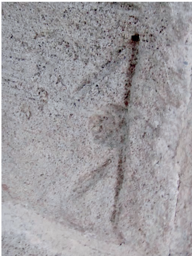
Figura 6. Fotografía de un sillar próximo al comienzo de la decoración de la cara este de la "Tour Hassan" (Rabat, Marruecos), realizadas en 2015; la imagen presenta una de las marcas reseñadas en el texto, que probablemente sea lo que resta de un breve y esquemático texto, una vez eliminado el almohadillado de manera parcial (foto del autor).
