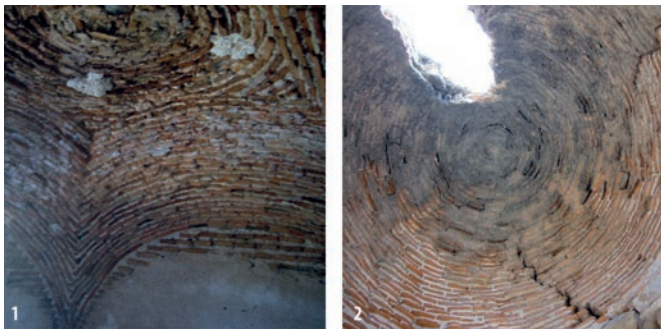
Figura 22. Bóvedas de la zona de estudio: 1) Bóveda de arista construida por hojas de geometría vaída de la Torre de San Andrés (2015); 2) Cúpula de ladrillo de la Torre de la Campana del castillo de Cogolludo (2007). Fotografías del autor.
