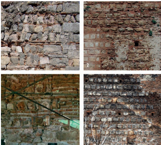
Figura 18. Ejemplos de esquinales en algunos de los edificios mencionados en el texto: 1) Torre de la Campana del castillo de Cogolludo (2007); 2) Fachada intramuros de la Puerta de la Villa de Buitrago (2015); 3) Fachada oeste de la Torre de San Andrés de Sepúlveda (2013); 4) Esquina de la torre sur del Arco de la Villa de Ayllón (2010). Fotografías del autor.
