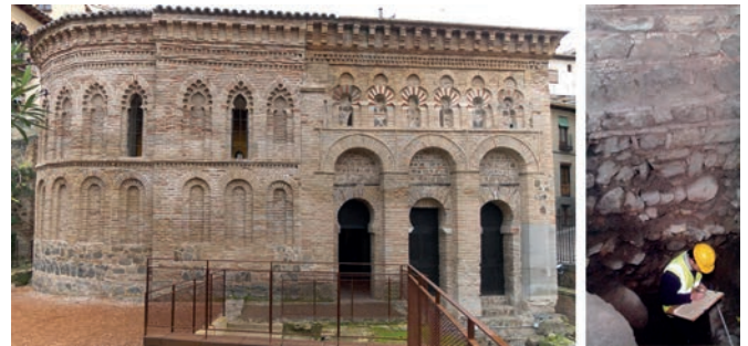
Figura 20. Vista exterior de la fachada norte de la mezquita de Bab al-Mardum o ermita del Cristo de la Luz de Toledo (Fotografía: Wikimedia commons). A la derecha, detalle de la cimentación del muro este de la mezquita durante los trabajos de excavación arqueológica donde se pueden ver algunos ladrillos a sardinel enmarcando mampuestos (Fotografía: Ruiz Taboada 2009: 64).
