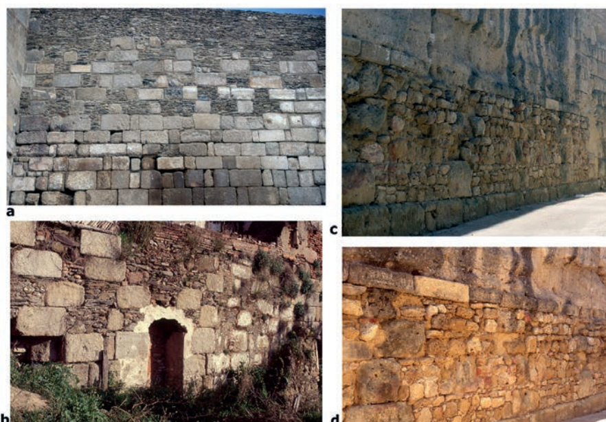
Figura 10. Aparejos en damero en al-Ándalus: a y b.- Coria (Cáceres); c y d.- Muralla de Carmona (Sevilla) (fotografías del autor).
