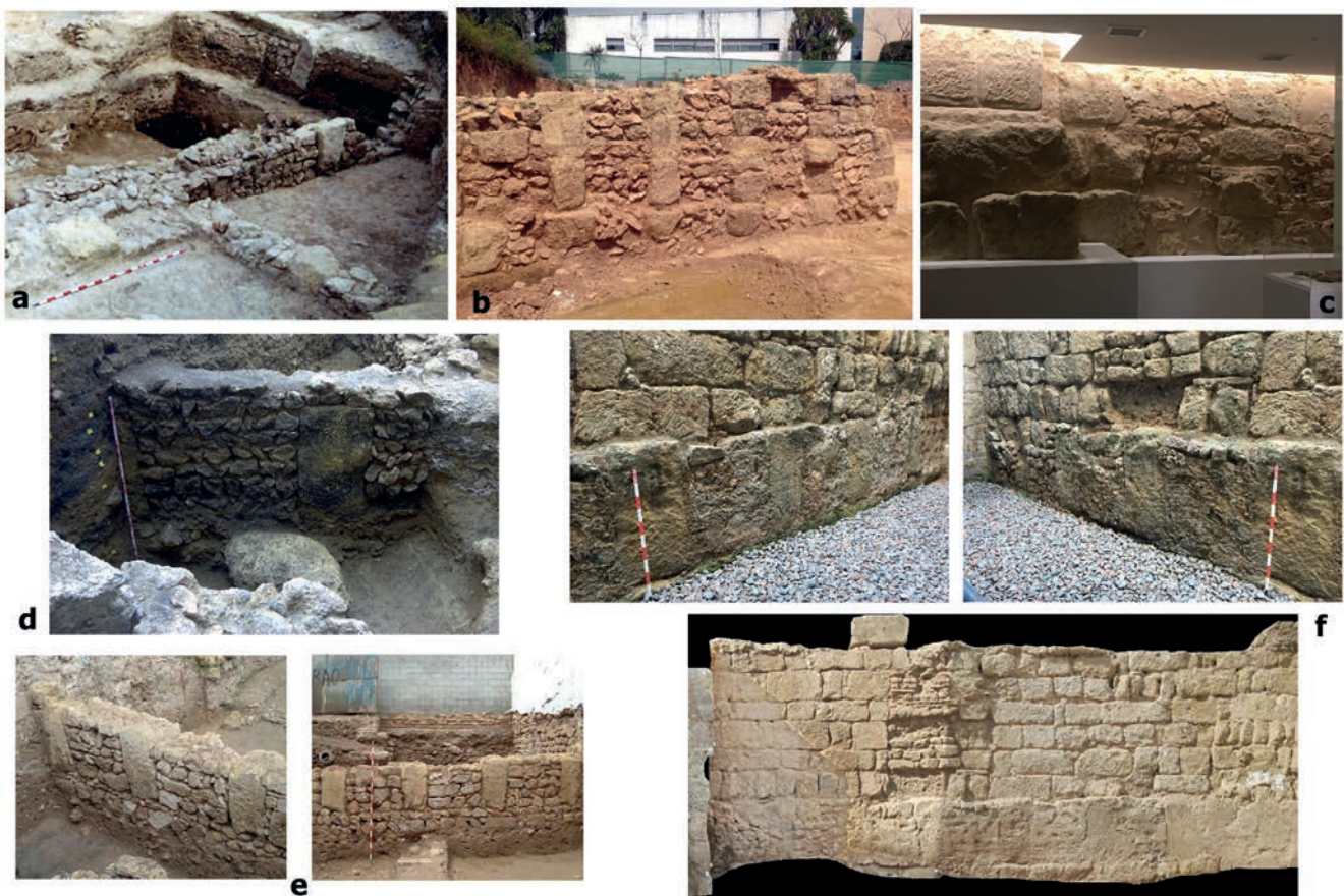
Figura 7. Aparejos con la técnica de encadenados verticales de sillería de época emiral en Córdoba: a.- Zoológico Municipal de Córdoba (Ruiz Lara et alii 2008); b y c: Hospital La Arruzafa, (esquina entre la C/ Poeta Valdelomar Pineda y la C/ Marino Alcalá Galiano) (fotografías del autor); d.- C/ Albéniz, nº 2 (Ortiz Urbano 2009); e.- C/ Antonio del Castillo, nº 3 (Ruiz Nieto 2009: 1194); f.- Parking la Mezquita de Córdoba, C/ Cairuán, nº 1 (alzado tomado de Vargas 2012 y fotografías del autor).
