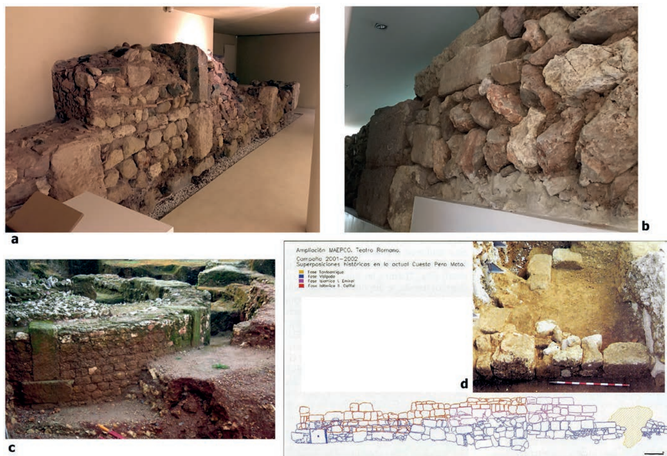
Figura 2. Paramentos de época tardoantigua en Córdoba en los que se emplea el opus africanum : a y b.- Edificio excavado junto a la Puerta del Puente (en el solar del actual Centro de Recepción de Visitantes; c.- Detalle de una de las tres estructuras semicirculares adosadas al muro del pódium del anfiteatro (Rodríguez et alii 2016; © GMU-UCO); d.- Estructuras tardoantiguas documentadas en la excavación del antiguo teatro romano de la ciudad (Monterroso y Cepillo 2002).
