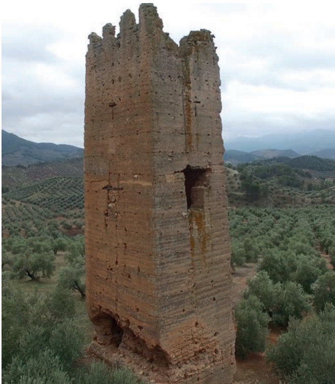
Figura 16. Torre sur de Santa Catalina. Su acceso se sitúa en la cara norte a una altura de 6,85 m. Además en la cara este existe otro hueco con el dintel de madera original que fue cegado también con tapial. La torre aún conserva intactos todos los merlones en una de sus caras. Fuente: autor.
