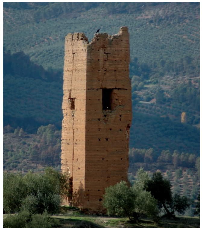
Figura 17. Torre norte de Sta. Catalina. También tiene dos aperturas o vanos originales situados a 7,18 m de altura. Tanto en esta torre como en la torre sur se aprecian los mechinales para introducir rollizos de sujeción de las plataformas de acceso. Son orificios pasantes toda la anchura del muro y que se han encofrado durante la ejecución de la fábrica para dejarlos previstos una vez terminada ésta. Fuente: autor.
