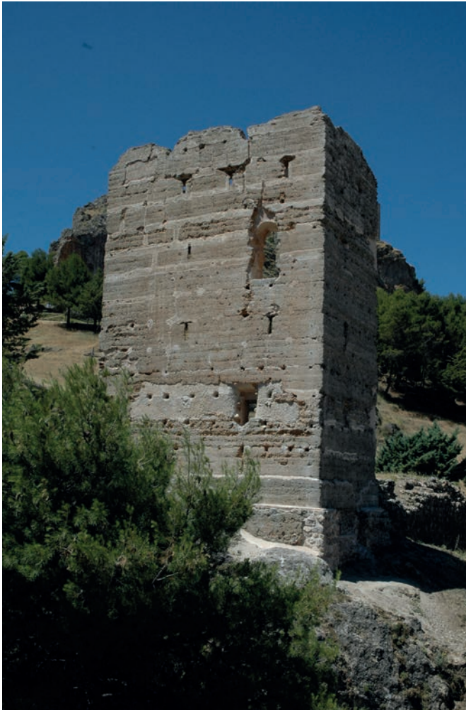
Figura 11. Torre de Góntar (Segura de la Sierra) tras su restauración en 2009. Es la única torre del sistema cuya función era exclusivamente defensiva, tal y como demuestran las numerosas saeteras dispuestas en todos los niveles de la torre; todas ellas orientadas para batir la zona a proteger que era el camino que llegaba a Segura de la Sierra desde la población de Góntar. El hueco con el medio punto es una apertura realizada a posteriori de la construcción original. Fuente: autor.
