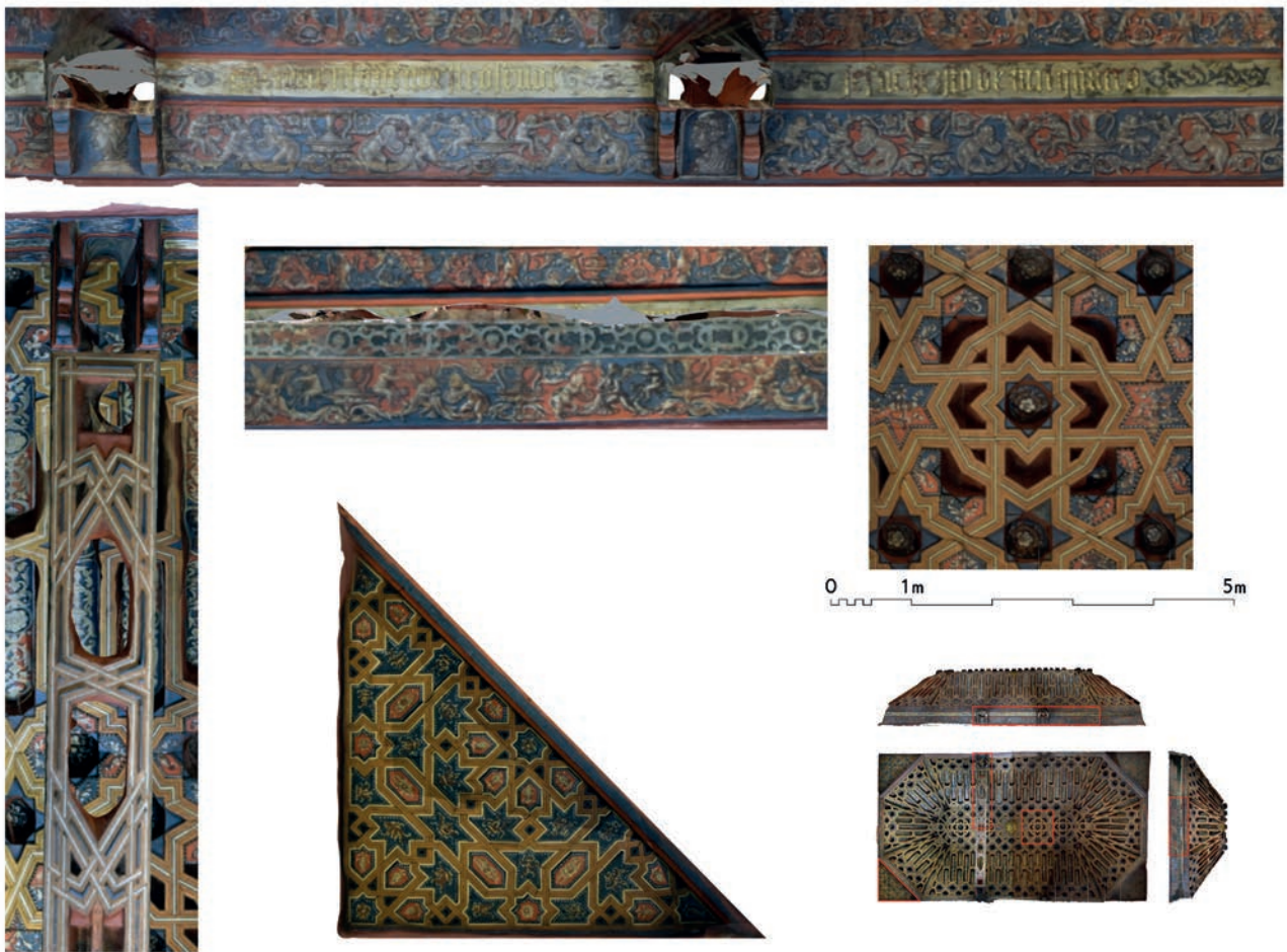
Figura 8. Ortofotos de distintos detalles de la armadura.
