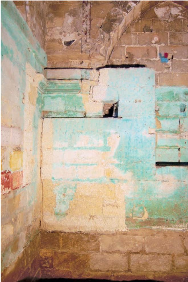
Figura 25. Intervención en el s. XIX en las molduras y el arcosolio del muro 9-A-C.
