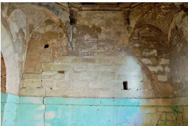
Figura 26. Intervención en el s. XIX. Cegado del arco rehundido en 7-C-A.
