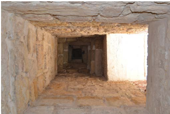
Figura 10. Bóveda por aproximación de hiladas vista desde el interior de la torre occidental de la Puerta del León (recinto primero).
