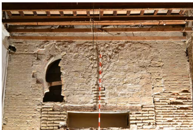
Figura 14. Descubrimiento del arco geminado perteneciente a la alcoba oeste del palacio islámico en el inmueble nº 7-8 del Patio de Banderas.
