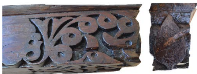
Figura 25. Detalle de la decoración de uno de los canes pertenecientes al alfarje original del palacio islámico (visión lateral y frontal).
