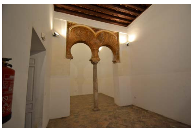
Figura 4. Arcos geminados conservados en el inmueble nº 2 del Patio de Banderas.
