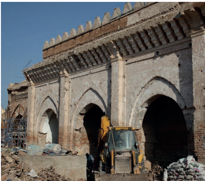
Fig. 24. Mezquita de la Qaşba. Frente septentrional durante las obras de 2012. Secuencia de vanos. Fotografía de Antonio Almagro.
