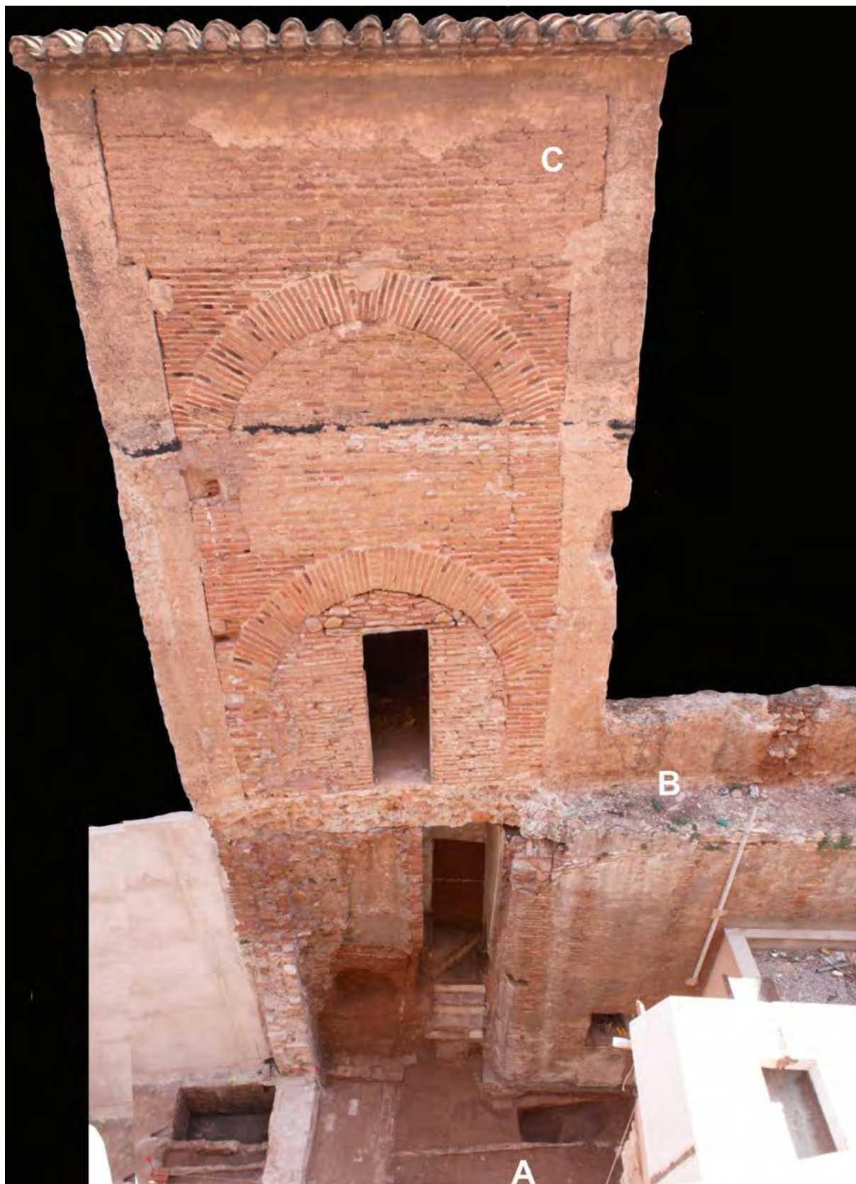
Figura 11. (A) Restos del tapial de la muralla localizados en la base de la torre del Racó de l'Abadia; (B) Parapeto del paso de ronda que se conserva sobre el muro de la antigua sacristía; (C) Cuerpo superior de la torre. Fotografía: autores.
