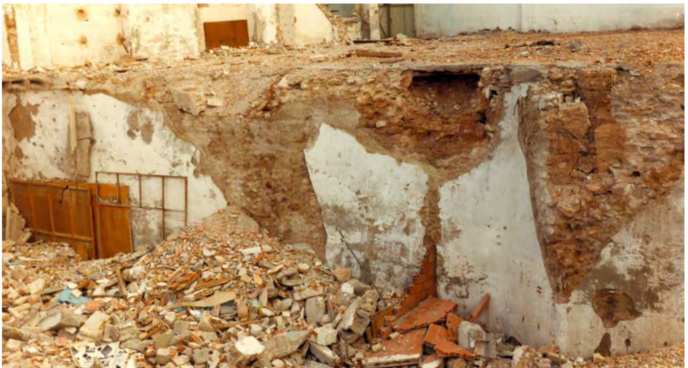
Figura 4. Trabajos de derribo del inmueble de Talleres Tormo que se llevaron a cabo sin vigilancia arqueológica. Fotografía: autores.
