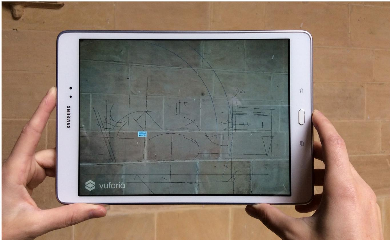
Figura 9. Aspecto que presentan los trazados y monteas superpuestos mediante realidad aumentada con la imagen instantánea de uno de los alzados del claustro. (Foto J. M. Valle, 2018).
