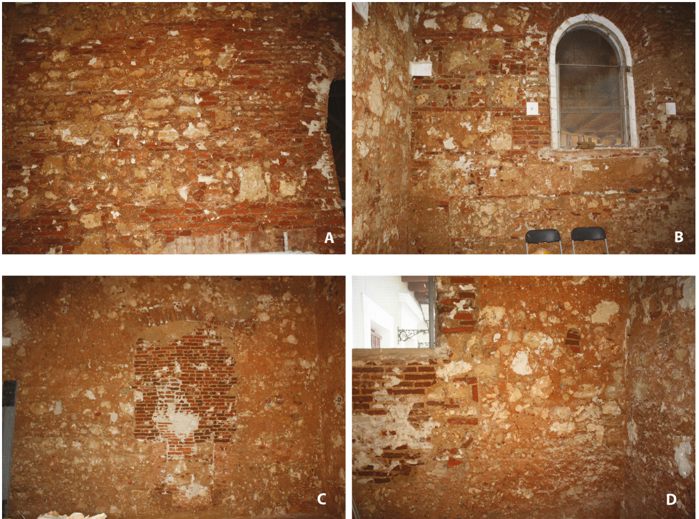
Figura 10. Muros de la Capilla de Belén; A-B: fábrica de mampostería encadenada en ladrillos con verdugadas (salón oeste, ca. 1858-63); C-D: mampostería ordinaria (salón este, ca. 1635-41).
