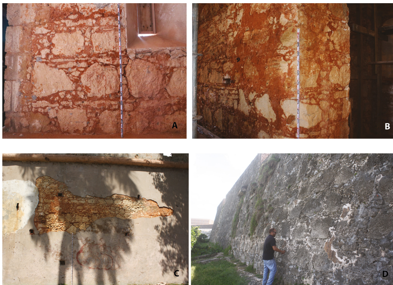
Figura 9. Variedades de mampostería careada con ripios; A: muro oeste nave central; B: esquina muro norte nave central (ca 1641); C: muro de contención, Jardines Occidentales, Casa Blanca (1841-45); D: variación en sillarejo concertado, Bastión de Ochoa, San Felipe del Morro (ca 1650).
