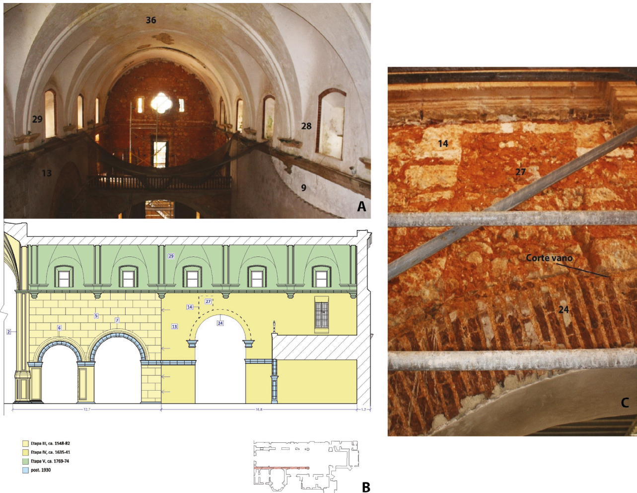
Figura 25. Nave central; A: vista de la nave central y la bóveda de ladrillos asociada a la Etapa 5; B: alzada sur de la nave central que muestra sus etapas constructivas; C: vista del arco de acceso a Rosario y corte de la ventana para la construcción del arco.
