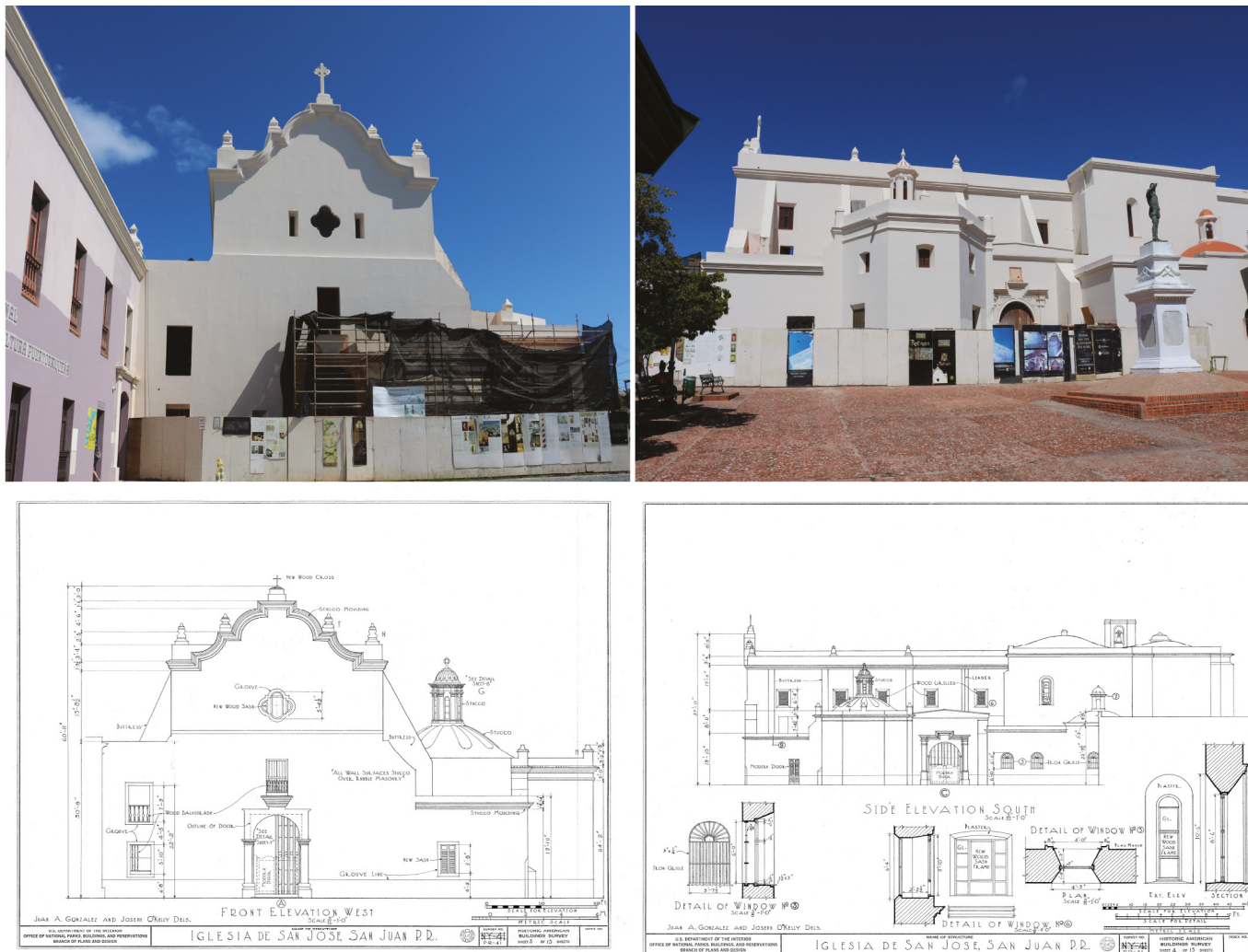
Figura 3. Parte superior: varias perspectivas de las condiciones actuales de la iglesia: izquierda, fachada principal; derecha, fachada sur; dibujos a escala de las mismas fachadas de las fotos superiores. Fuente: Historic American Buildings Survey. US Department of Interior, National Park Service. Survey No. PR-41. Index No. 7-SAJU-1.
