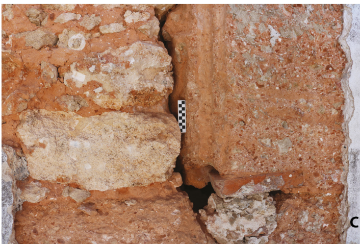
Figura 8. Tipologías de muros identificados en el polígono del s. XVI; A: Tipo 1, tapia encadenada en mampostería con verdugadas (muro este, ábside); B: Tipo 3, tapia encadenada en mampostería y reforzada con sillares (muro sur, transepto); C: Tipo 2, tapia encadenada en mampostería con grieta en la juna entre ambas fábricas (muro este, ábside); D: Tipo 3, tapia encadenada en mampostería y reforzada con sillares (muro exterior sur, transepto).
