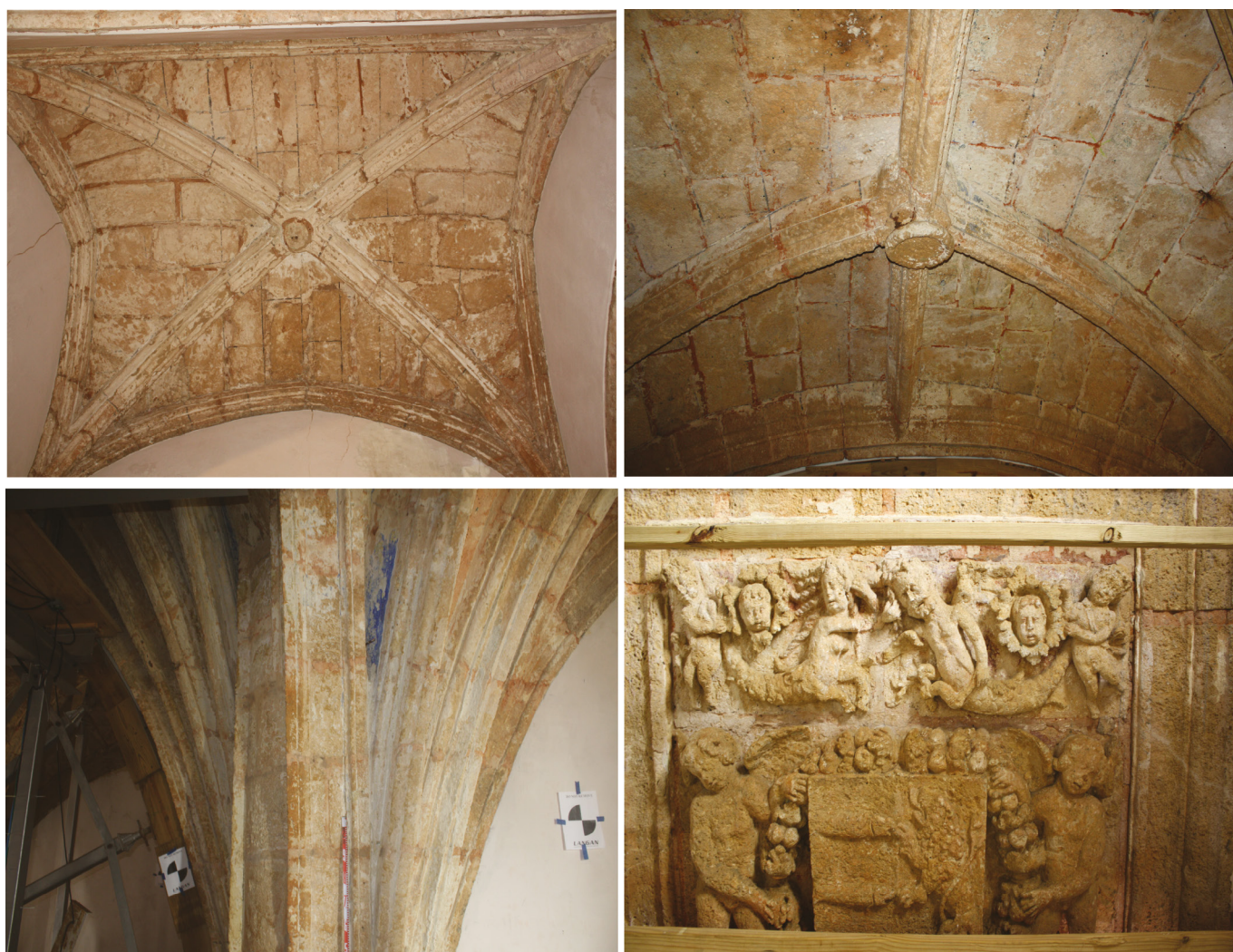
Figura 6. Varios ejemplos de las bóvedas y otros trabajos en sillería: izquierda superior, bóveda nave lateral sur; derecha superior, detalle nervaduras, bóveda transepto; izquierda inferior, detalle nervaduras de la pilastra sureste entre transepto y ábside; derecha inferior, tarja que detalla el escudo de la familia García Troche-Ponce de León. Parte superior muro norte, ábside.
