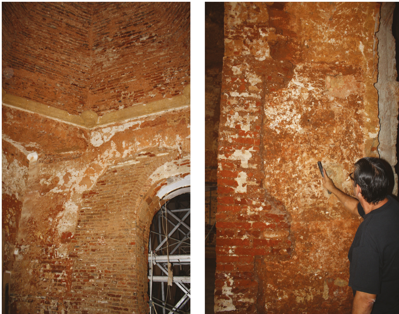
Figura 21. Elementos constructivos de la Capilla de Belén; izquierda: vista del muro norte, salón este con su bóveda octagonal. Derecha; adosamiento encastrado del muro norte de la capilla (salón oeste) al muro sur del transepto de San José.
