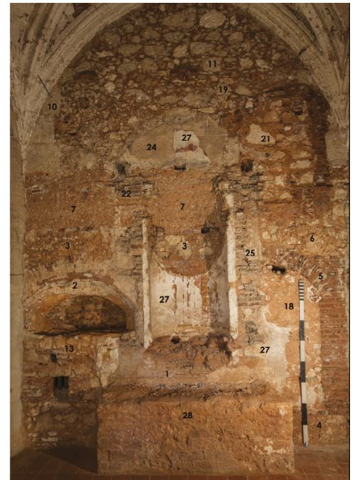
Figura 14. Alzada norte del paramento interior de la nave lateral norte (San Vicente Ferrer). En verde olivo las fábricas asociadas al convento de los dominicos; en anaranjado las fábricas que corresponden a la primera alzada; en amarillo fábricas de la segunda alzada y el resto de las modificaciones posteriores. Foto: Alberto Rigau.
