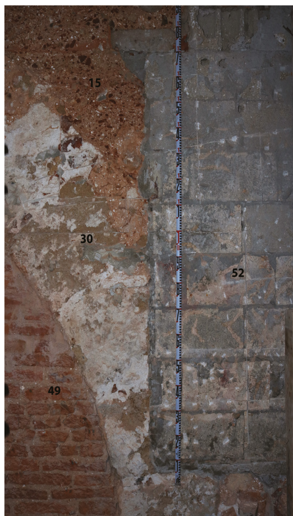
Figura 26. Alzado sur del paramento interior del transepto. Izquierda: en anaranjado las fábricas que corresponden a la primera alzada y en amarillo fábricas de la segunda alzada y el resto de las modificaciones posteriores. Derecha: detalle de corte para nicho tapiado en bloques de cemento.
