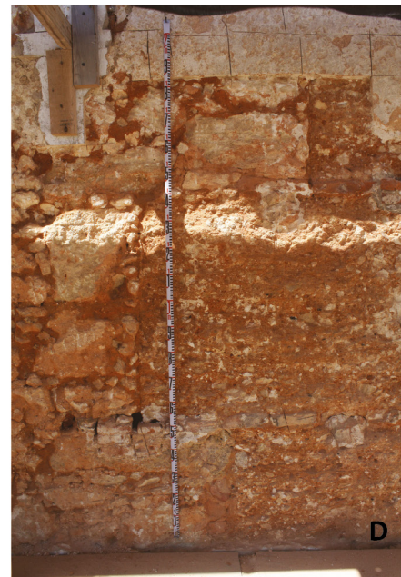
Figura 8. Tipologías de muros identificados en el polígono del s. XVI; A: Tipo 1, tapia encadenada en mampostería con verdugadas (muro este, ábside); B: Tipo 3, tapia encadenada en mampostería y reforzada con sillares (muro sur, transepto); C: Tipo 2, tapia encadenada en mampostería con grieta en la juna entre ambas fábricas (muro este, ábside); D: Tipo 3, tapia encadenada en mampostería y reforzada con sillares (muro exterior sur, transepto).
