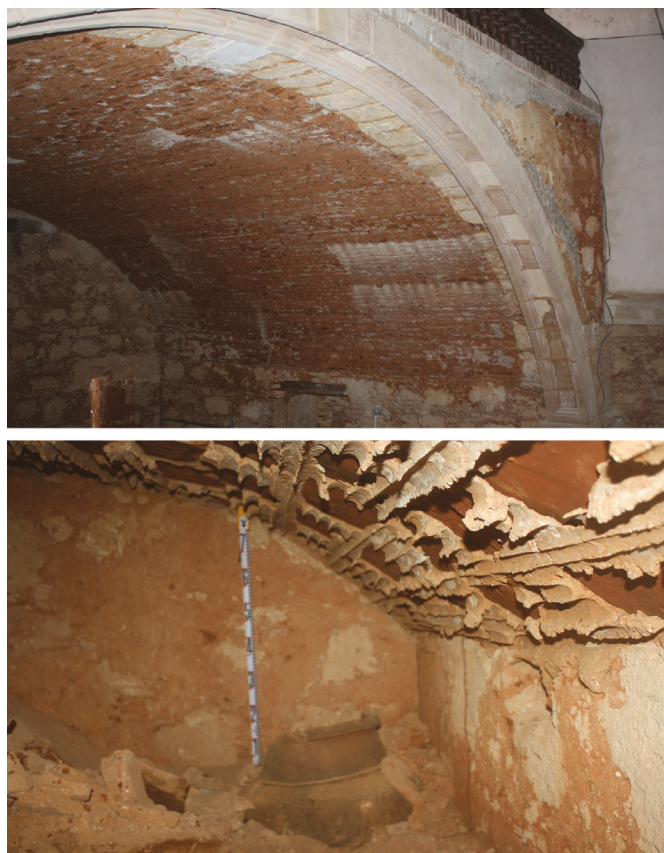
Figura 12. Arriba: vista del arco para el coro, construido en ladrillos rematado con sillarejos. Abajo: detalle de técnica para sujetar la cubierta superior con mortero y cañas colocadas transversalmente. En el fondo, tinaja utilizada como parte del relleno para la bóveda. Etapa 5.
