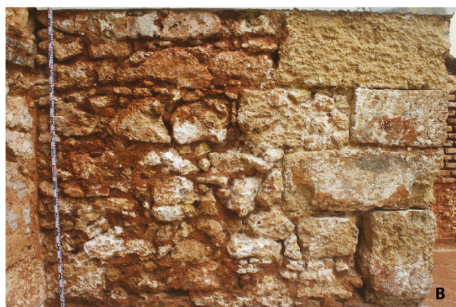
Figura 15. A: paramento exterior del este del transepto con el contrafuerte UEM 13 asociado a la iglesia gótica, y el UEM 34 asociado a la construcción de la capilla de Belén. B: fábrica de mampostería encadenada con sillares, primera alzada del contrafuerte UEM 13.
