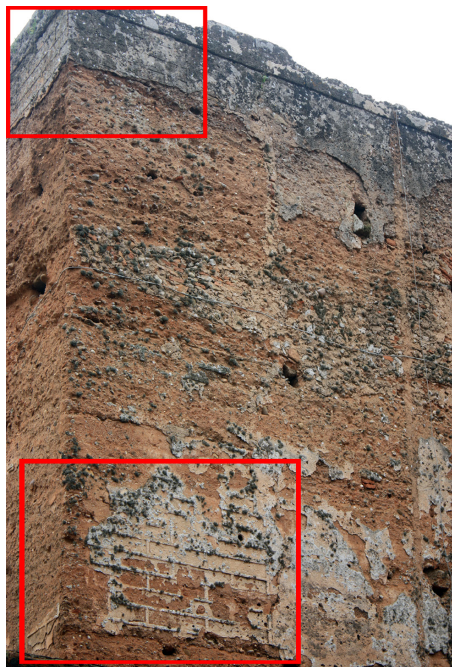
Figure 6. Enceinte de tābiya . Angle nord-ouest de la porte principale. Petit appareil de pierre de taille simulé par de faux joints de chaux (© Les auteurs).
