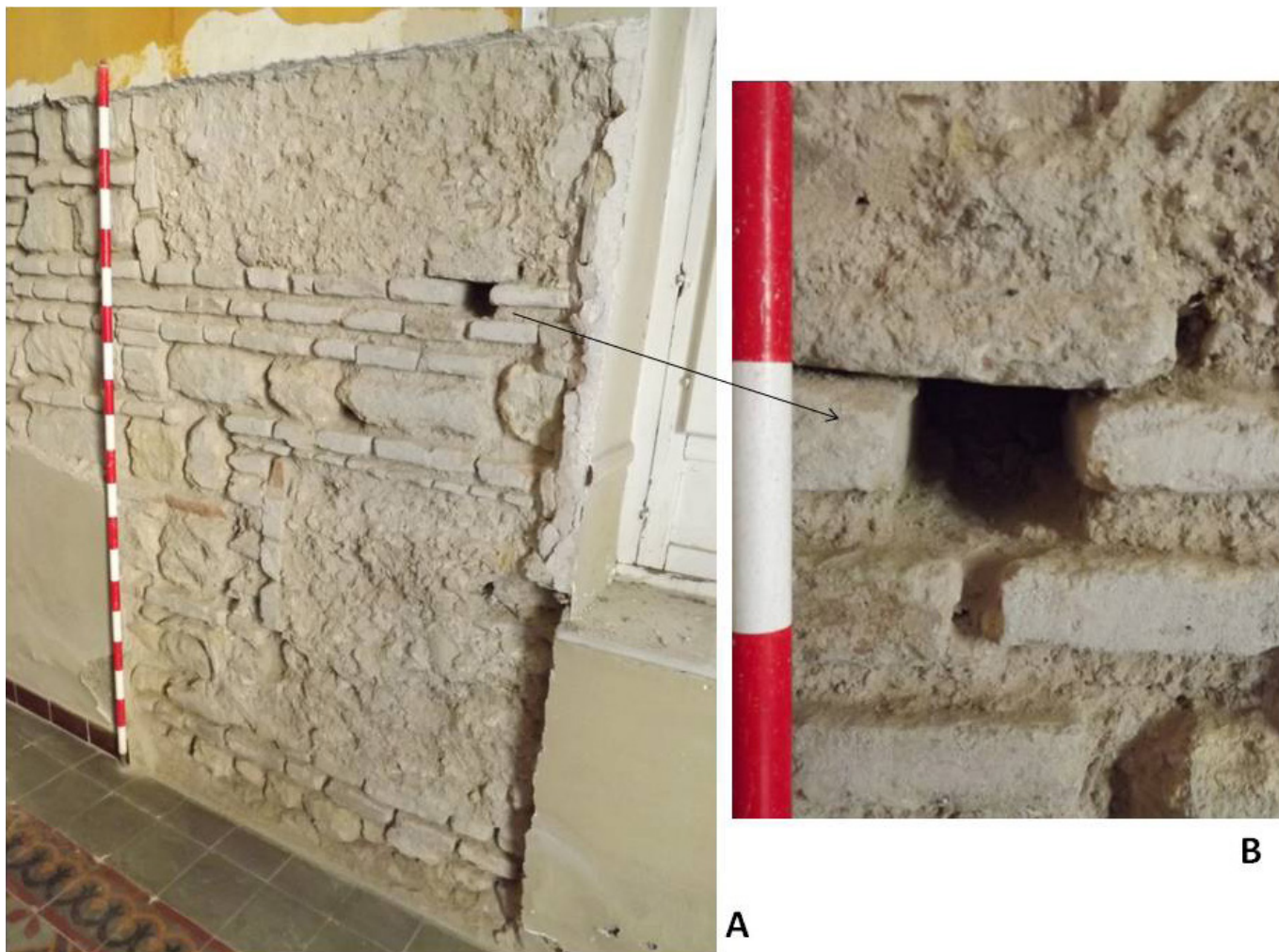
Figura 20. Tapial del Tipo 8 documentado en Portería de Santa Clara 4 y Osio 4. A. Detalle del paramento. B. Detalle de los agujales.
