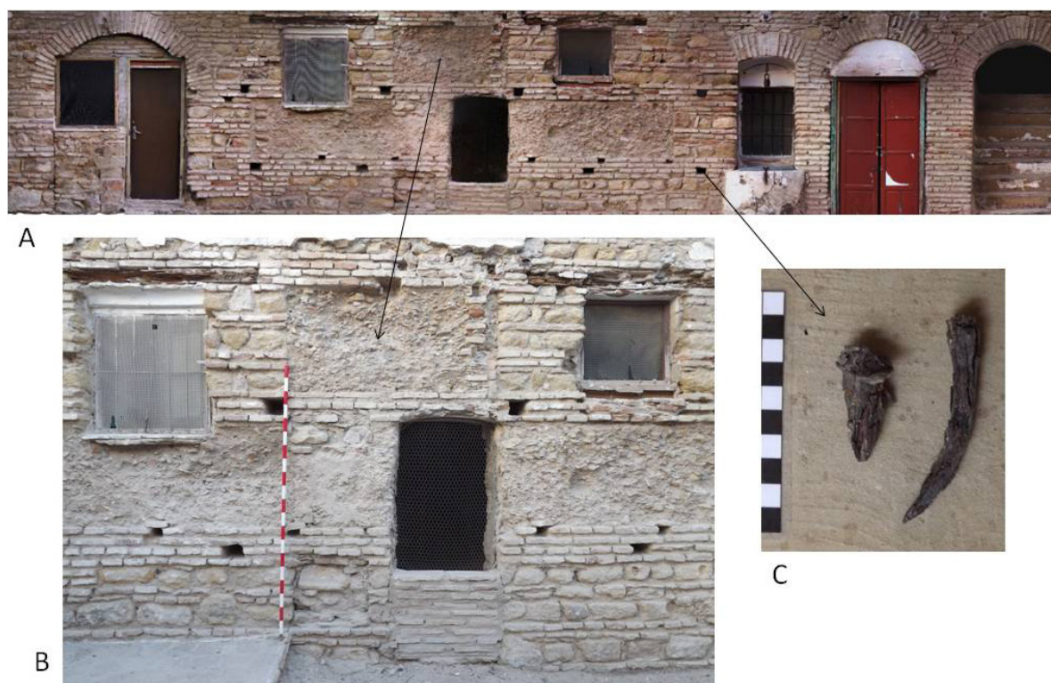
Figura 18. Tapial del Tipo 6 documentado en Albucahis 6. A. Detalle del paramento. B. Detalle de una sección del muro. C. Clavos documentados en uno de los mechinales de andamio.
