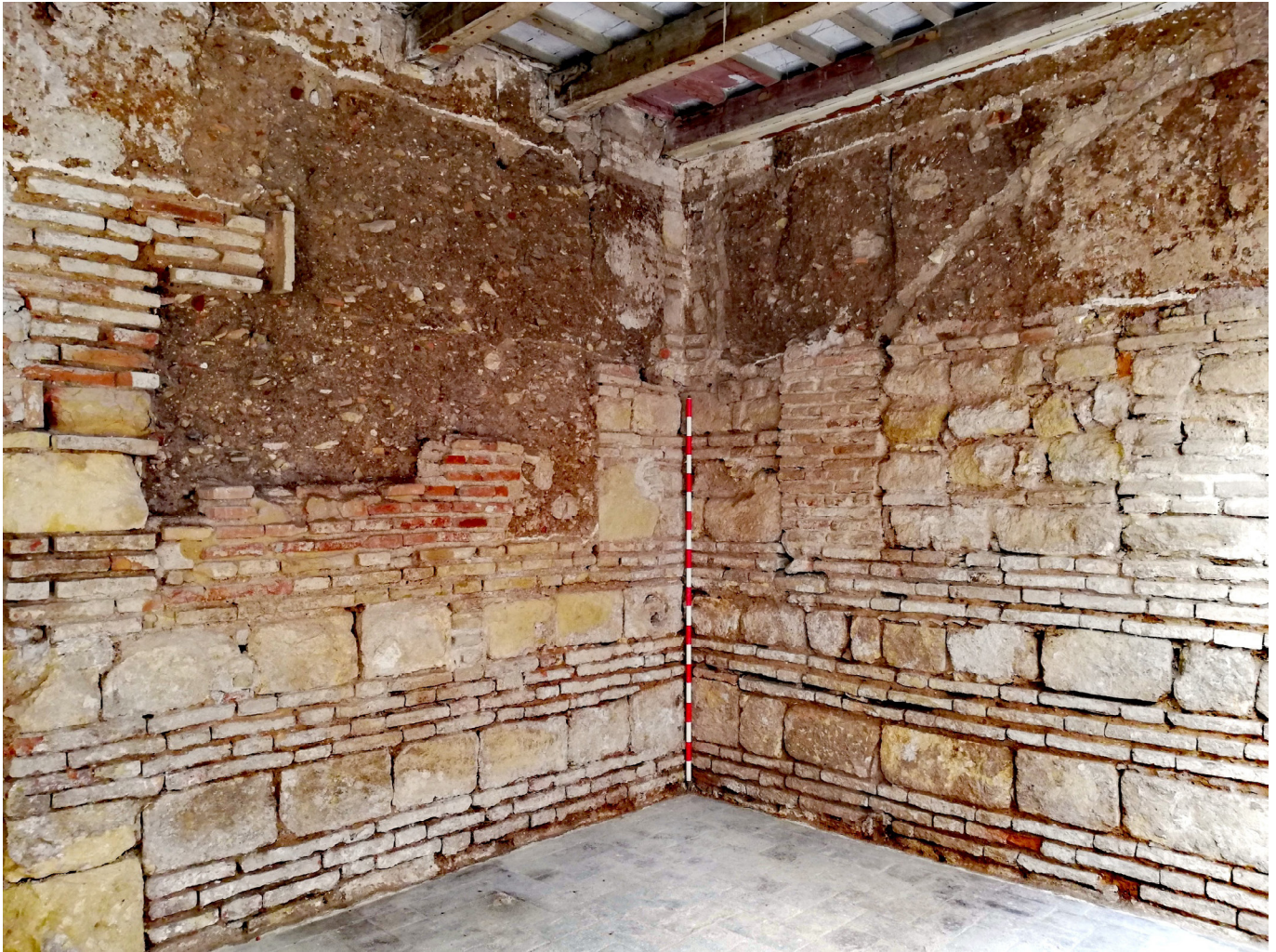
Figura 8. Detalle de la fábrica mixta utilizada en machones y pie de aguja en Calleja de las Flores 4.
