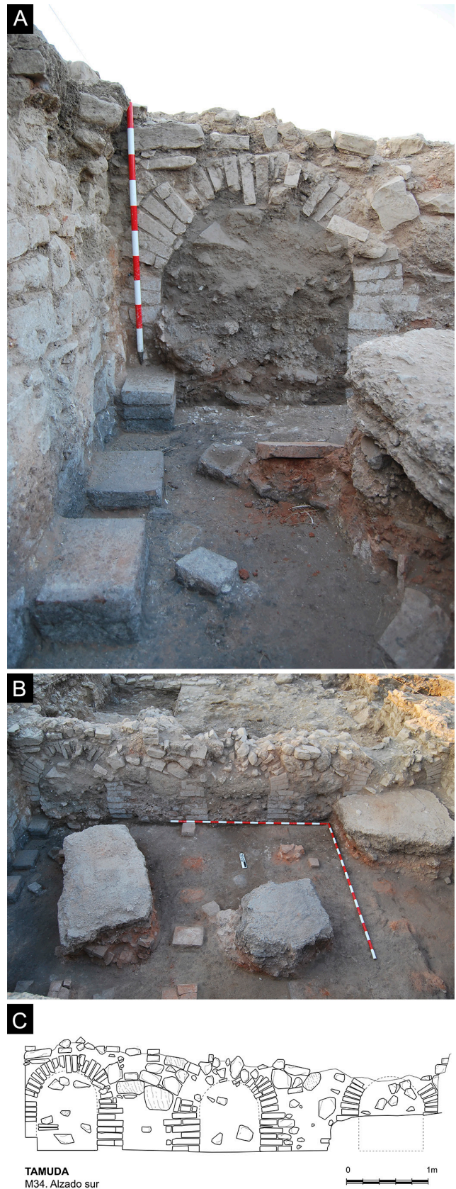
Figura 8. Muro divisorio de las salas calefactadas (M-34). Detalle del arco oriental del muro con detalle de las pilae del caldarium en primer plano (A). Fotografía (B) y dibujo (C) del alzado sur.
