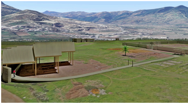
Figura 27. Cubierta del balneum . Vista general hacia el oeste. Muro de respaldo y de protección contra el viento. Integración con la línea del cielo y el paisaje.
